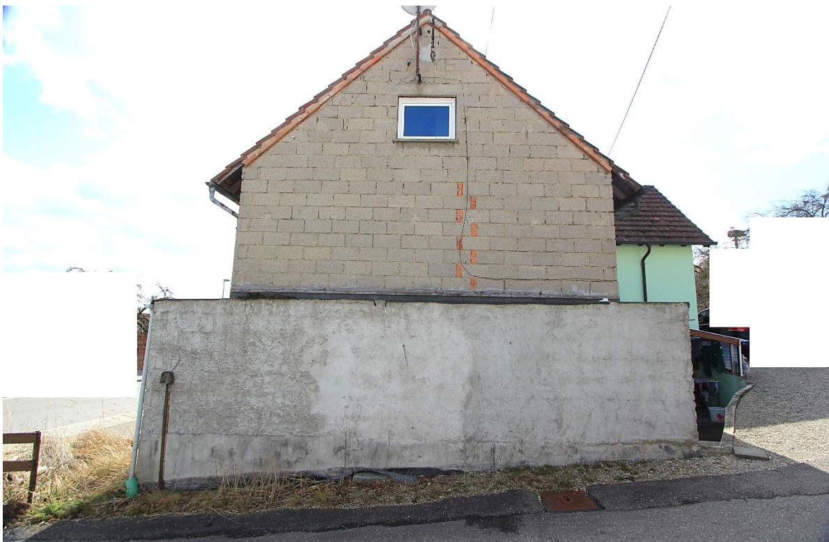
Nordseite Haushälfte, vorne Flachdachanbau
