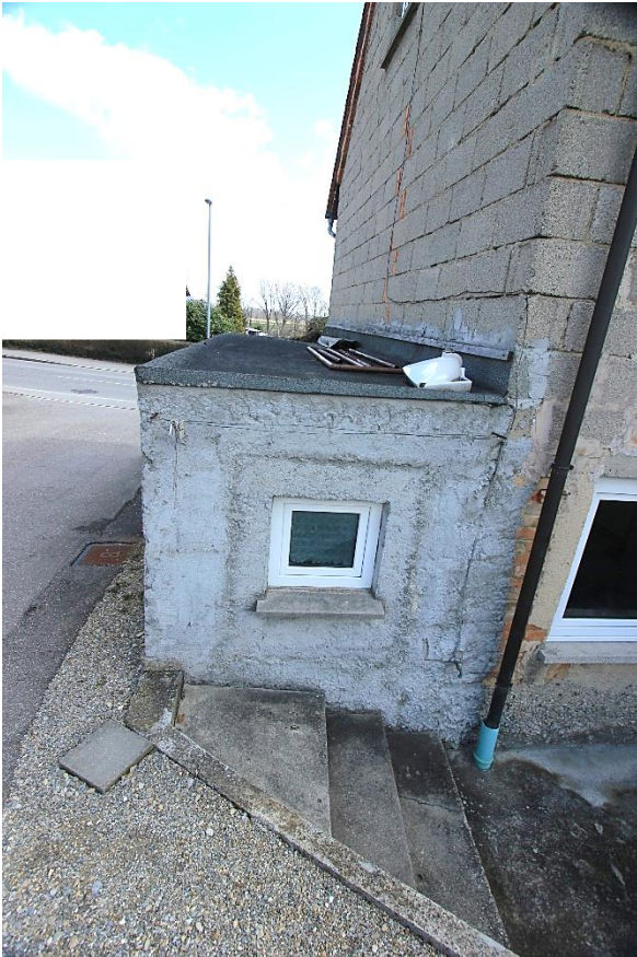
Westseite Flachdachanbau und Treppe
