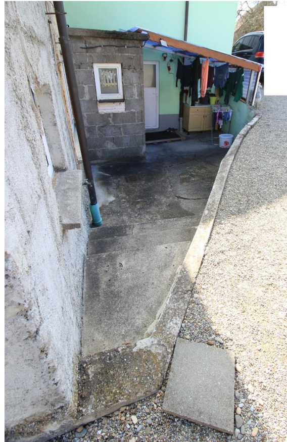
Tiefer liegender Hof von Norden
