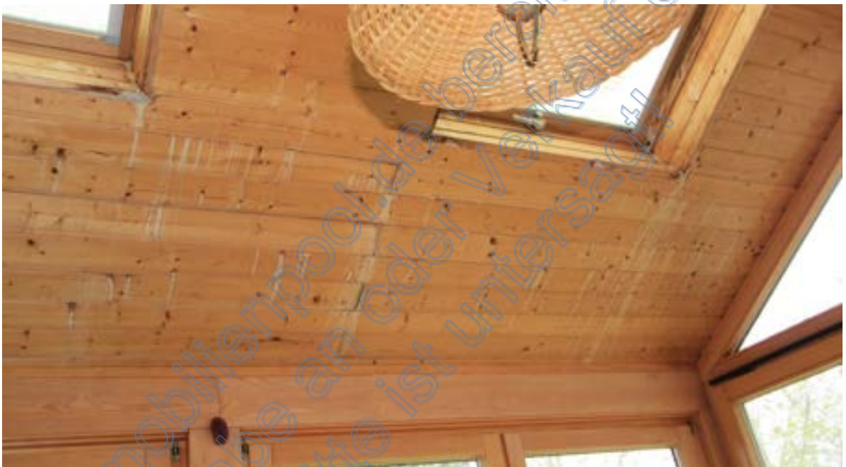
Feuchtflecken unter den Dachfenstern im Wintergarten
