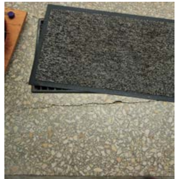
Riss im Bodenbelag im Windfang
