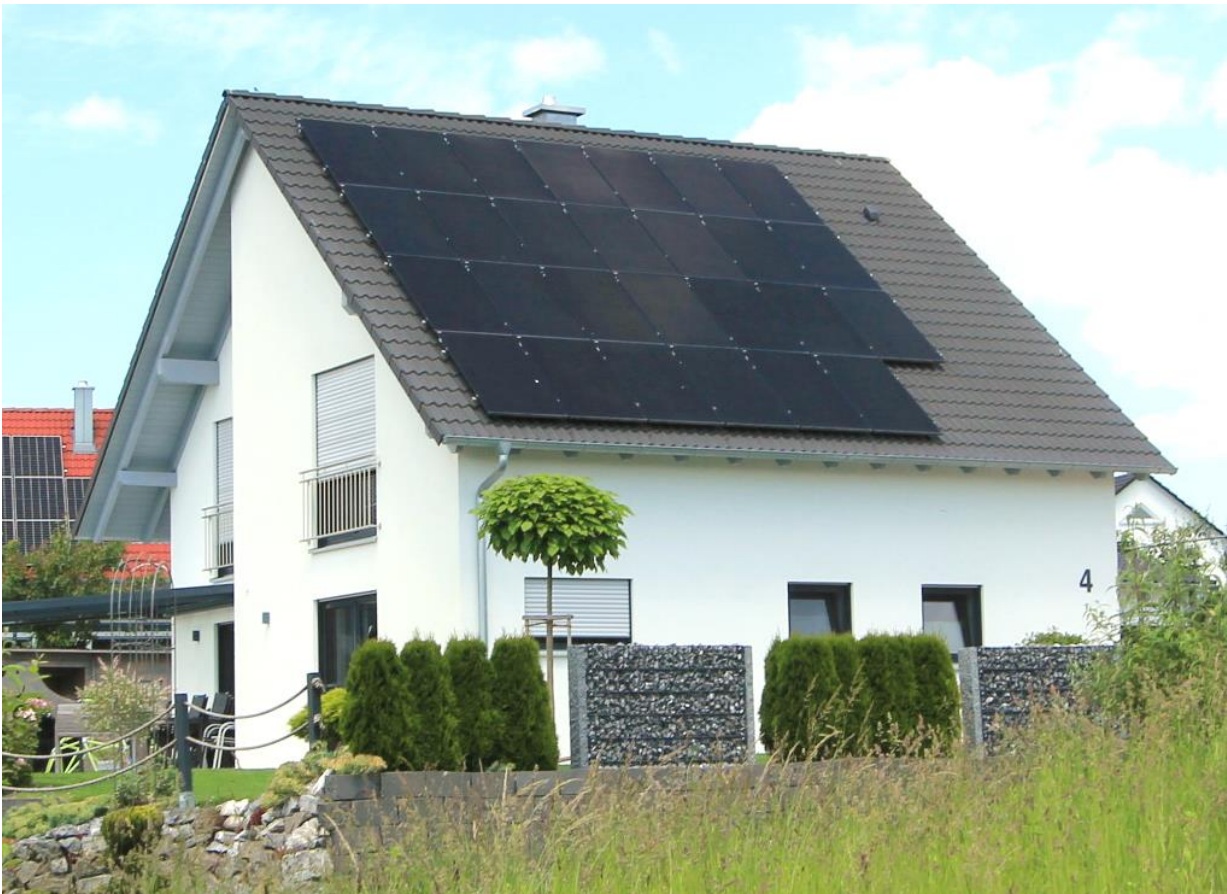
Wohnhaus mit Photovoltaikanlage von Südwesten
