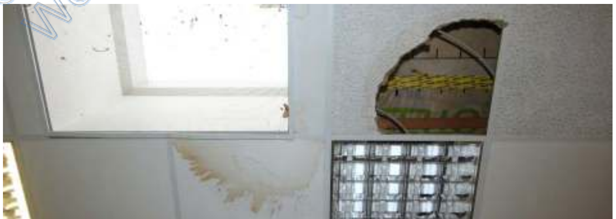
Wasserschaden an der abgehängten Decke
