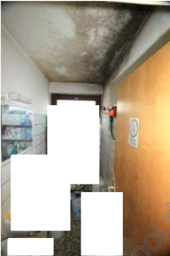
Alter WC-Raum mit Wasserschaden
