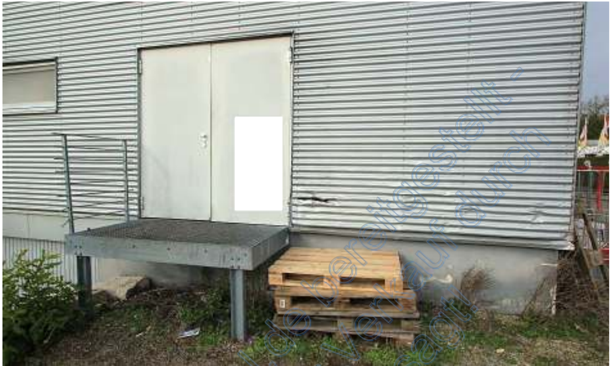
Anlieferpodest und Dellen an der Südfassade des Lagerraumanbaus
