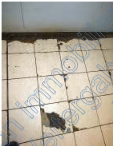
Fliesenschäden am Boden
