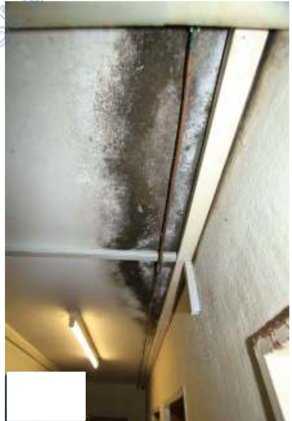
Wasserschaden an der Decke
