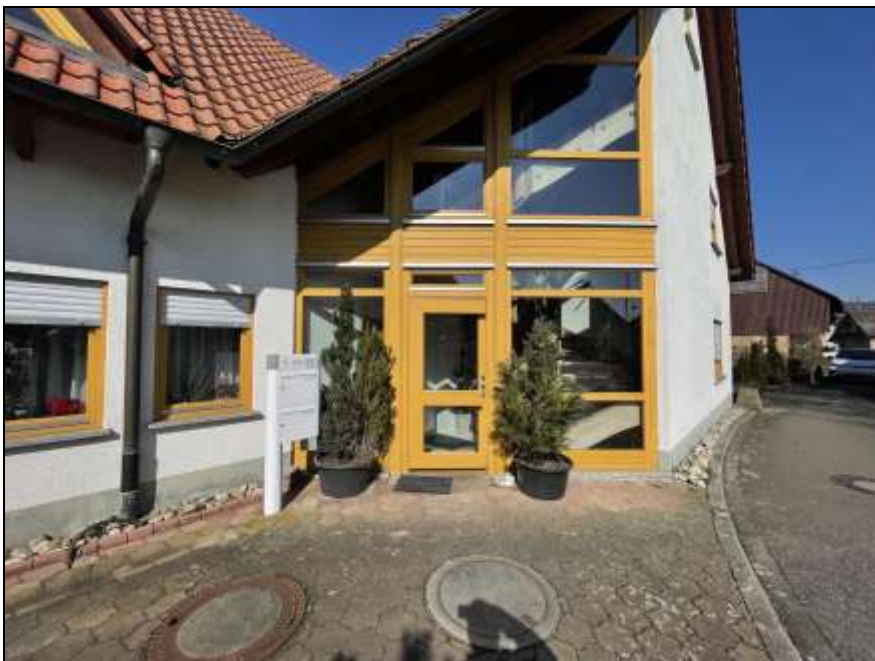
Bild 2: Eingang zum Werkstattbereich, Südwestseite
