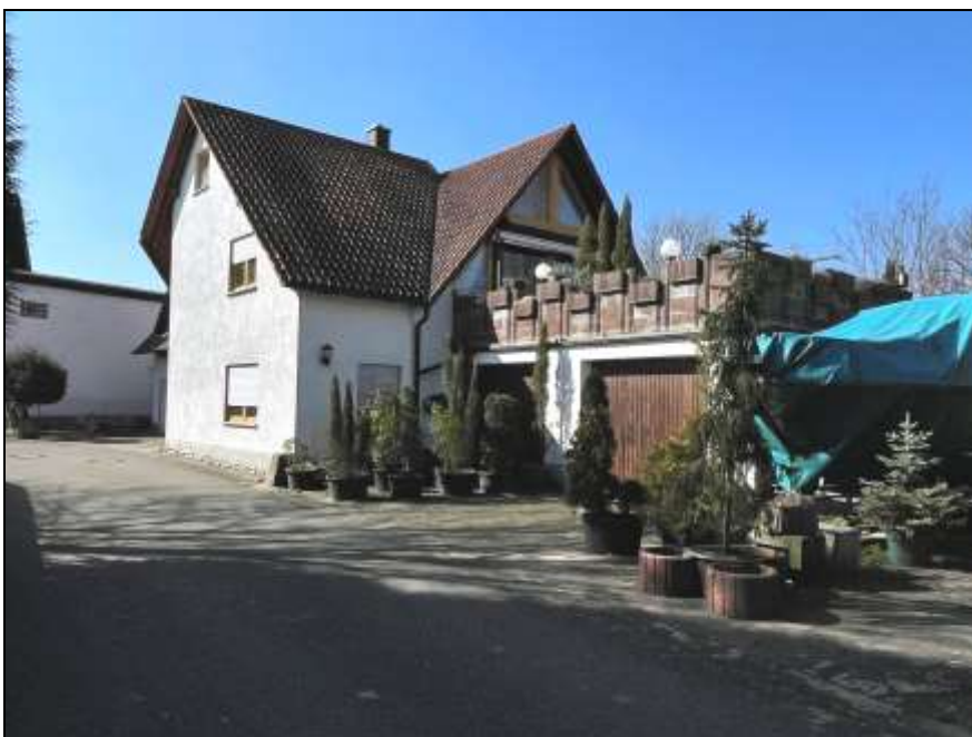
Bild 4: Wohn- und Geschäftshaus
