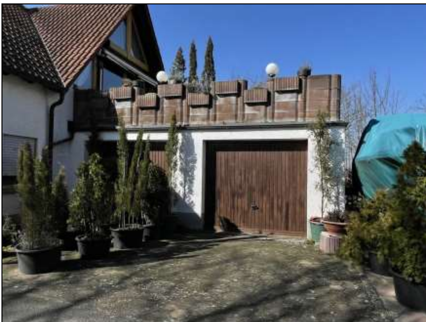
Bild 6: Pkw-Garagenanbau mit Dachterrasse
