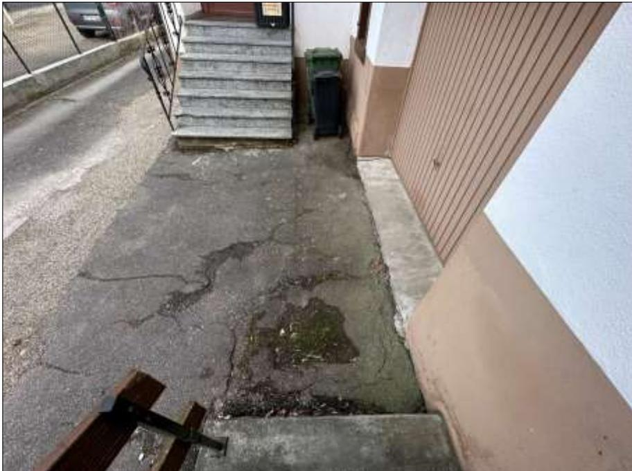
Bild 7: Hofbelag mit Rissen im Asphalt
