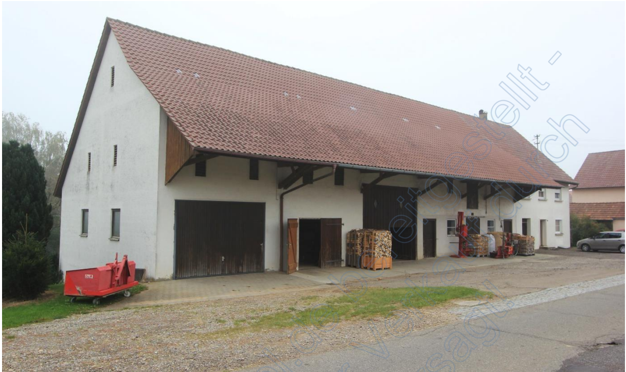
Wohnhaus/Stall/Scheuergebäude mit Hof von Nordwesten, links Maschinenraumanbau
