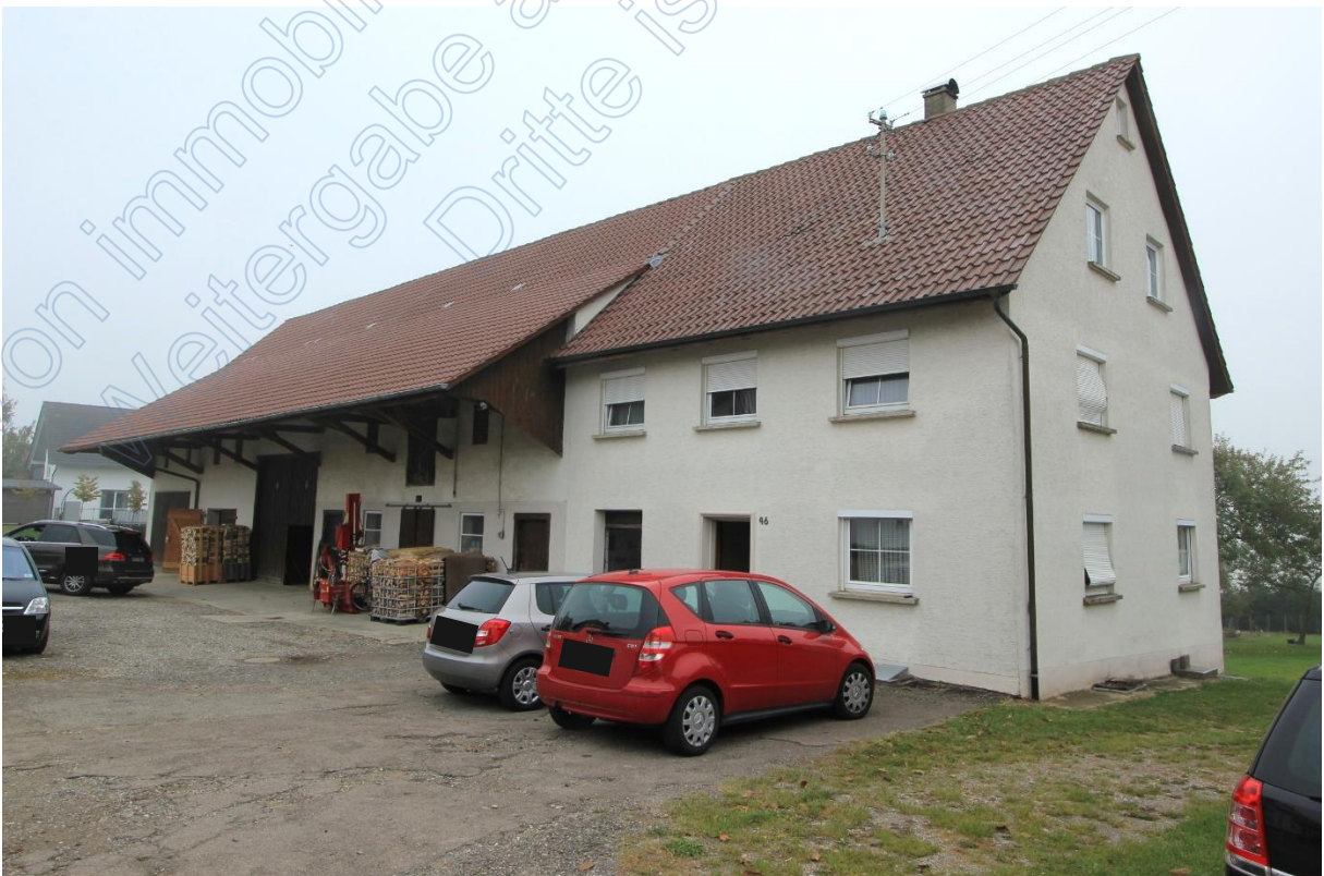
Wohnhaus/Stall/Scheuengebäude von Südwesten
