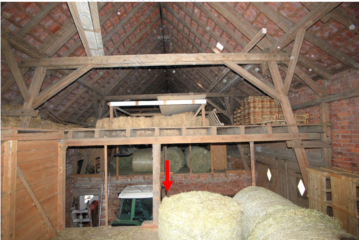
Dachraum Wirtschaftsgebäude, Pfeil Tenne
