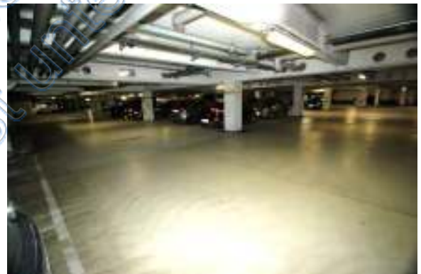
Blick in die Tiefgarage
