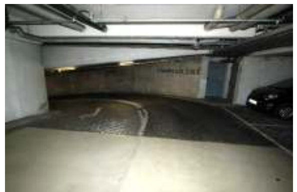
Abfahrt zum 2. UG in der Tiefgarage
