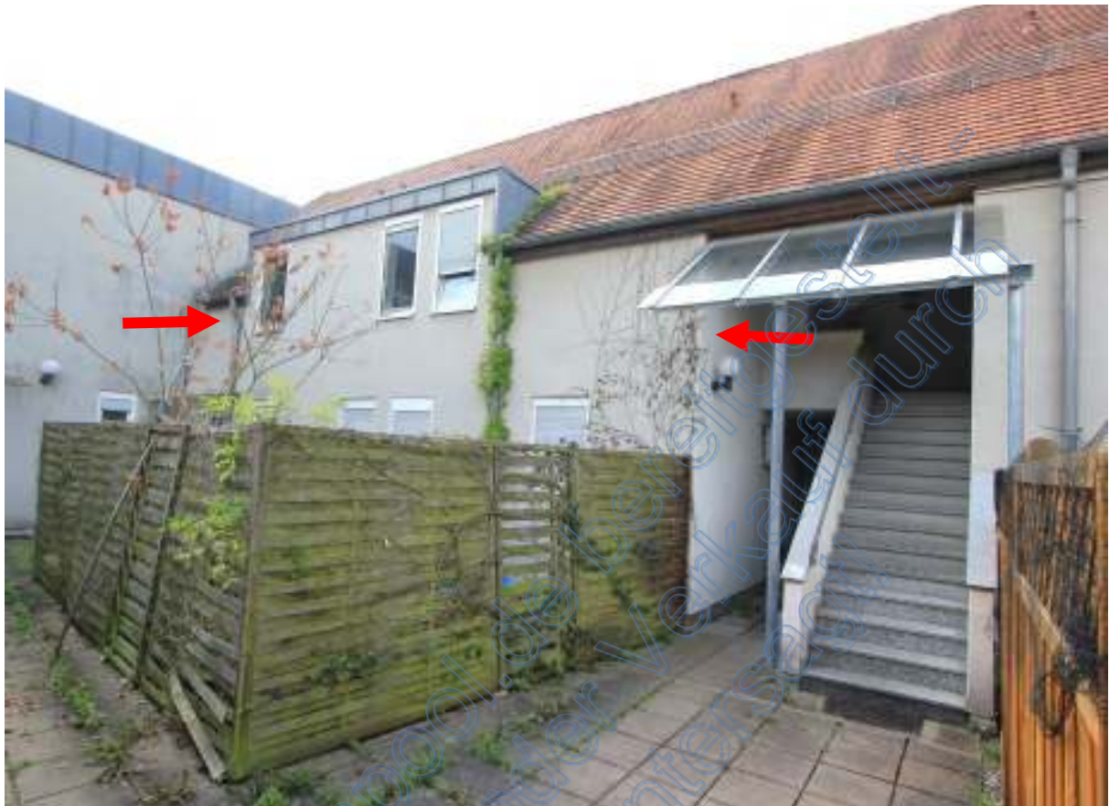
Ostseite Wohnhausriegel mit Aufgangstreppe, Pfeile Wohnung Nr. 25 im 3.OG mit Dachspitz
