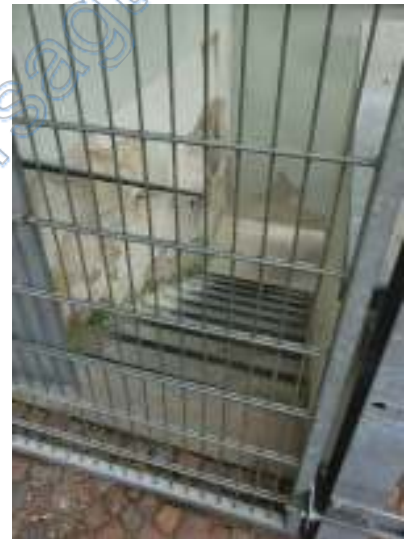
Treppe zur Tiefgarage
