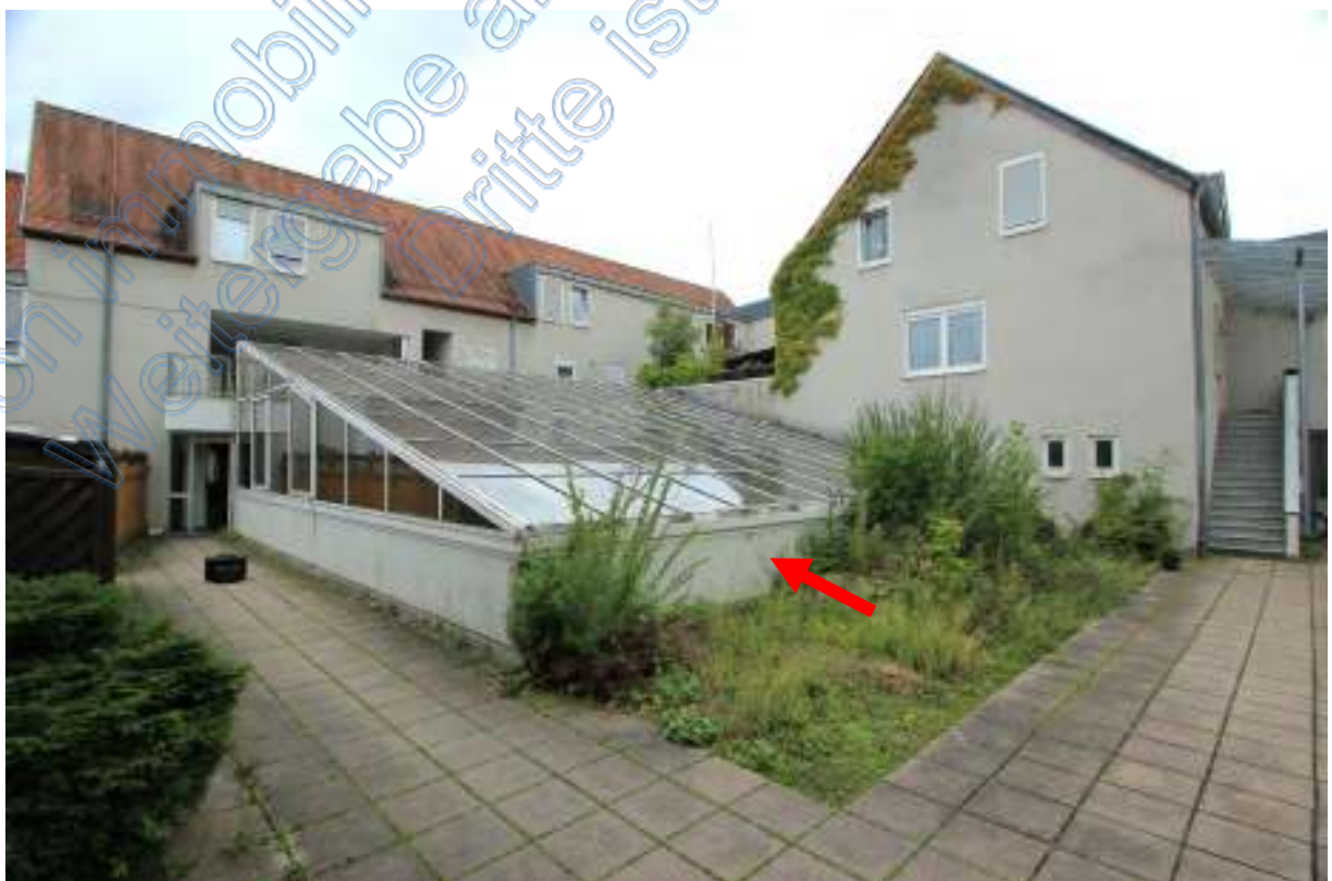
Flachdach mit Plattenwegen, links Ausgangstür, Pfeil Lichtdach über dem Gewerbezentrum
