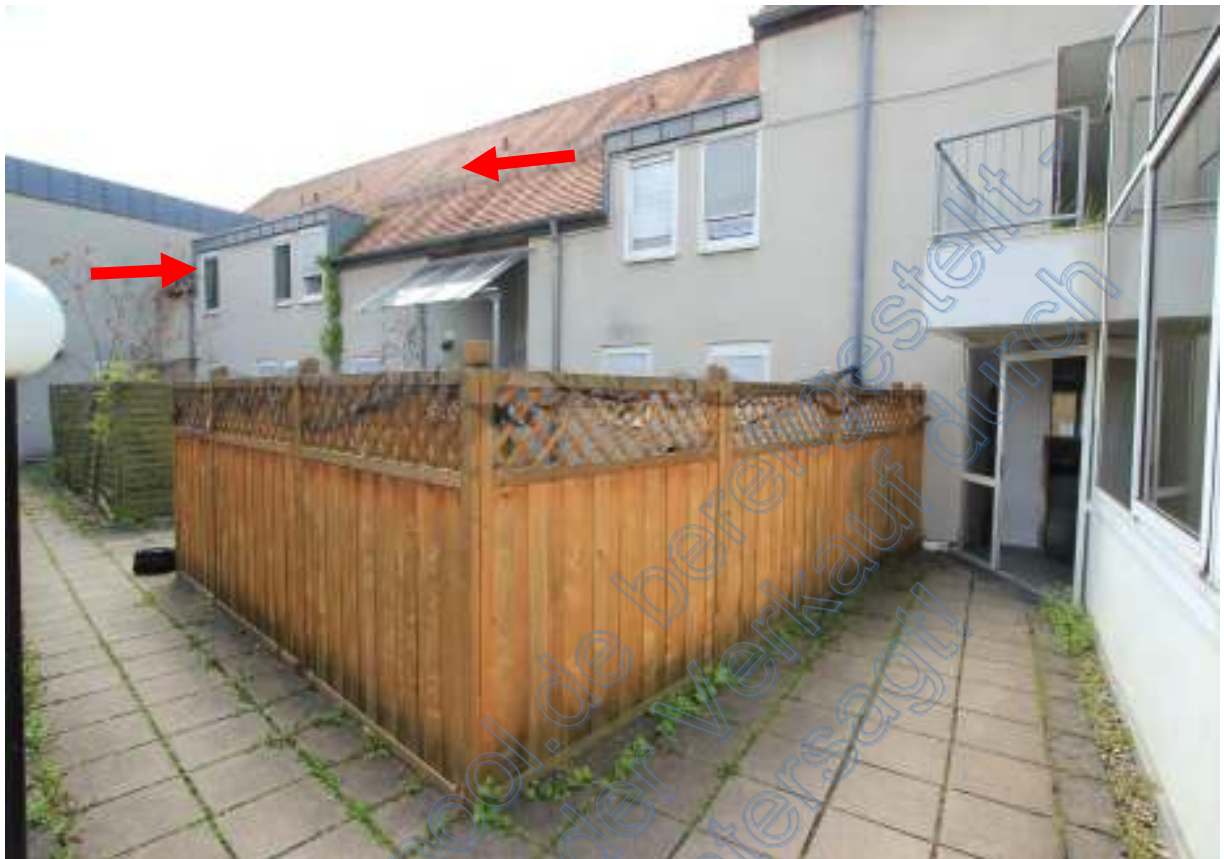
Flachdach mit Plattenwegen, rechts Ausgangstür, Pfeile Wohnung ATP Nr. 25
