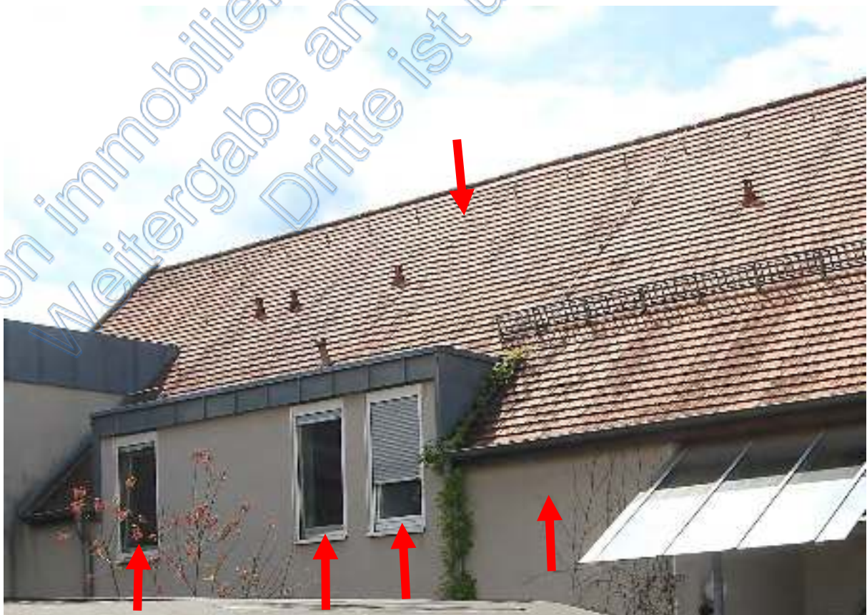
Ostseite, Pfeile Bad, Küche, Esszimmer, WC Nr. 25 im 3.OG, darüber Bühne im Dachspitz
