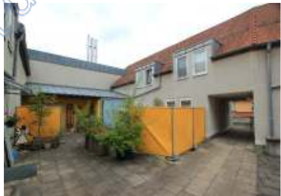
Hinterer Hinterhof, Blick nach Nordosten
