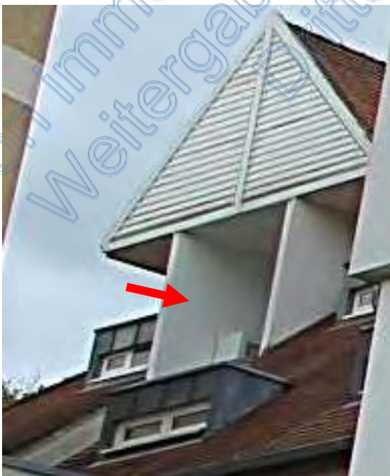
Südliche Loggia der Wohnung Nr. 25
