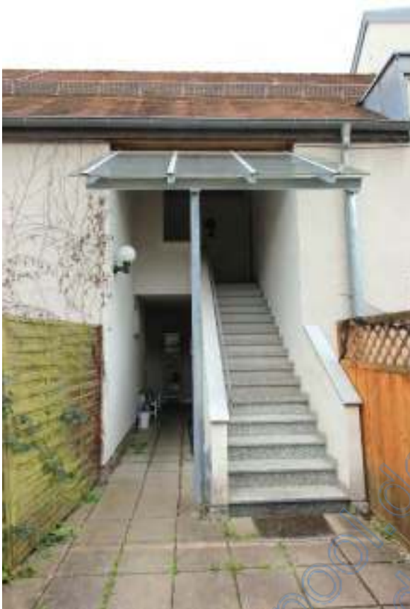
Aufgangstreppe zur Wohnung Nr. 25 im 3.OG
