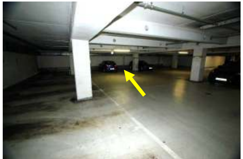
Tiefgarage im 1. UG, Pfeil derzeit genutzter Stellplatz
