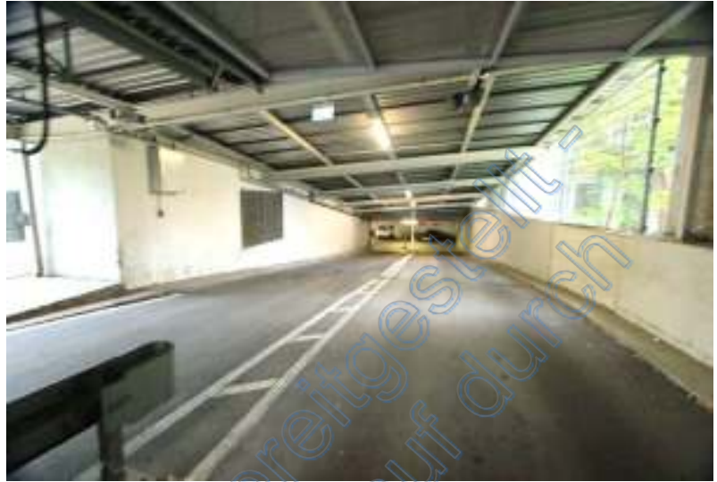
Tiefgaragenzu- und -ausfahrt
