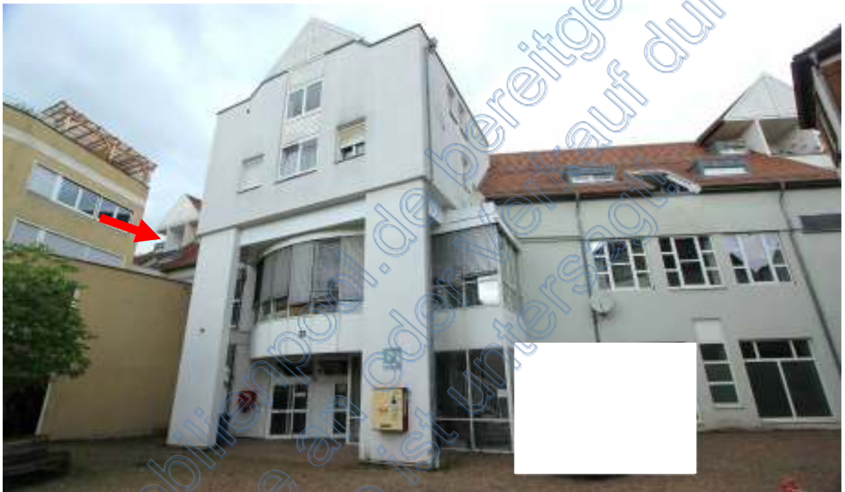
Südseite Eigentumsanlage mit stillgelegtem Haupteingang zu den Läden im EG, Pfeil Wohnung
