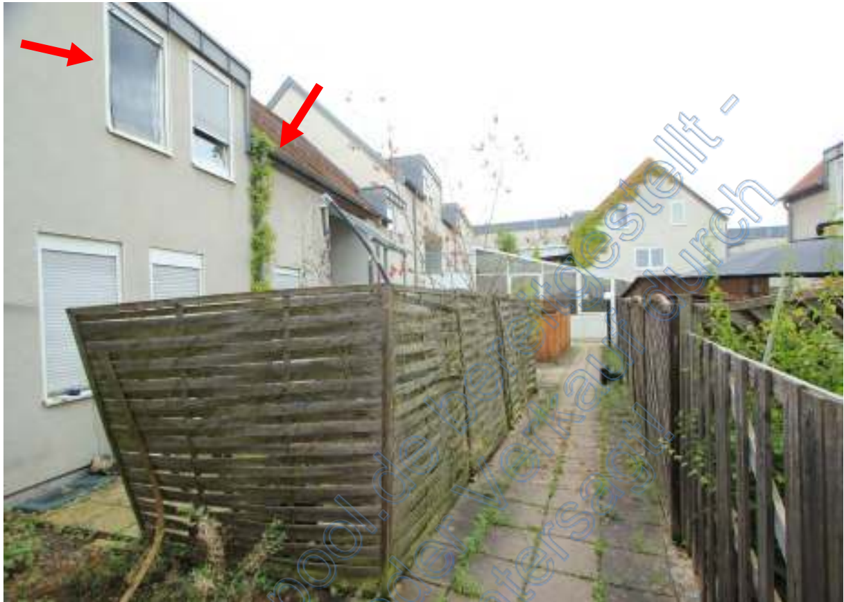
Plattenweg auf dem Flachdach und umzäunter Garten der Wohnung im 2. OG, Pfeil Nr. 25
