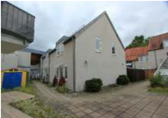
Innenhof auf dem Flachdach
