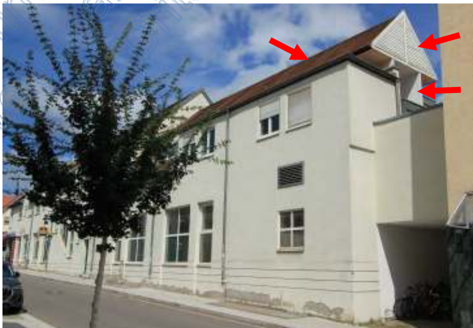
Blick von Südwesten, Pfeile Wohnung Nr. 25 im DG mit Bühne im Spitz
