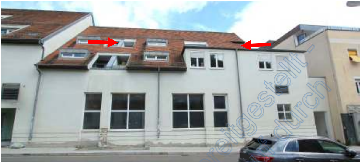
Südliche Westseite Eigentumsanlage an der Wielandstraße, Pfeile Wohnung Nr. 25 im DG
