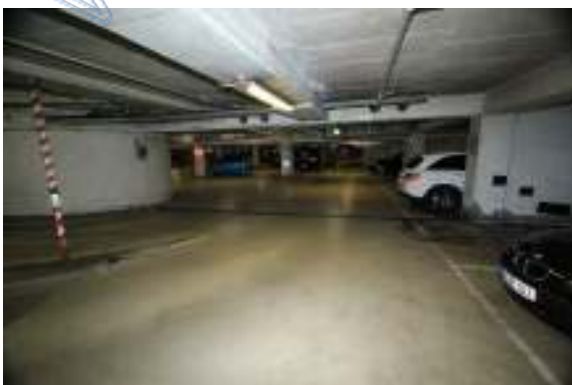
Zufahrt zur Tiefgarage 1. UG
