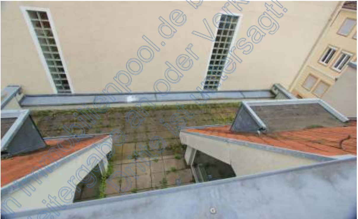
Südliche Loggia, Blick nach unten
