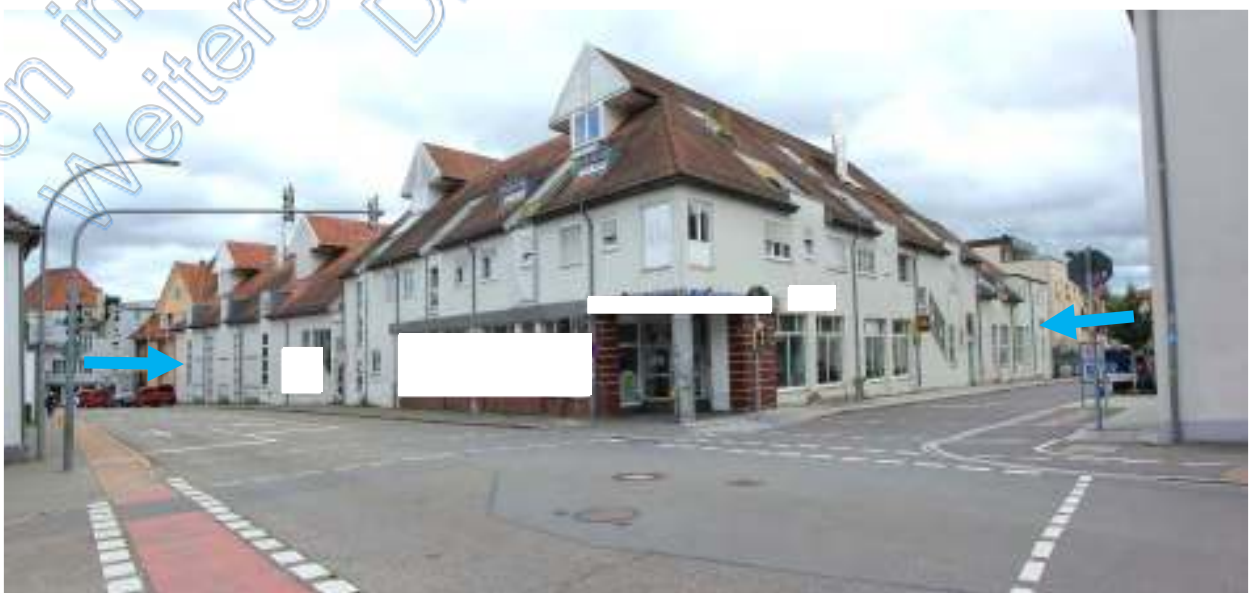
Anlage von Nordwesten, Pfeil links Nordseite Bismarckring, rechts Westseite Wielandstraße
