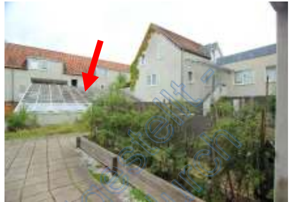
Innenhof auf dem Flachdach, Pfeil Glasdach
