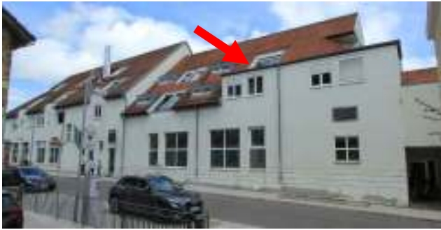
Westseite Eigentumsanlage, Pfeil Wohnung 25
