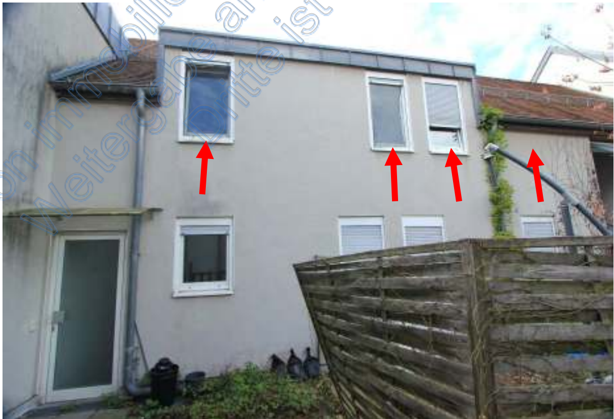
Ostseite Wohnhausriegel, Pfeile Bad, Küche, Esszimmer, WC der Wohnung Nr. 25 im 3.OG
