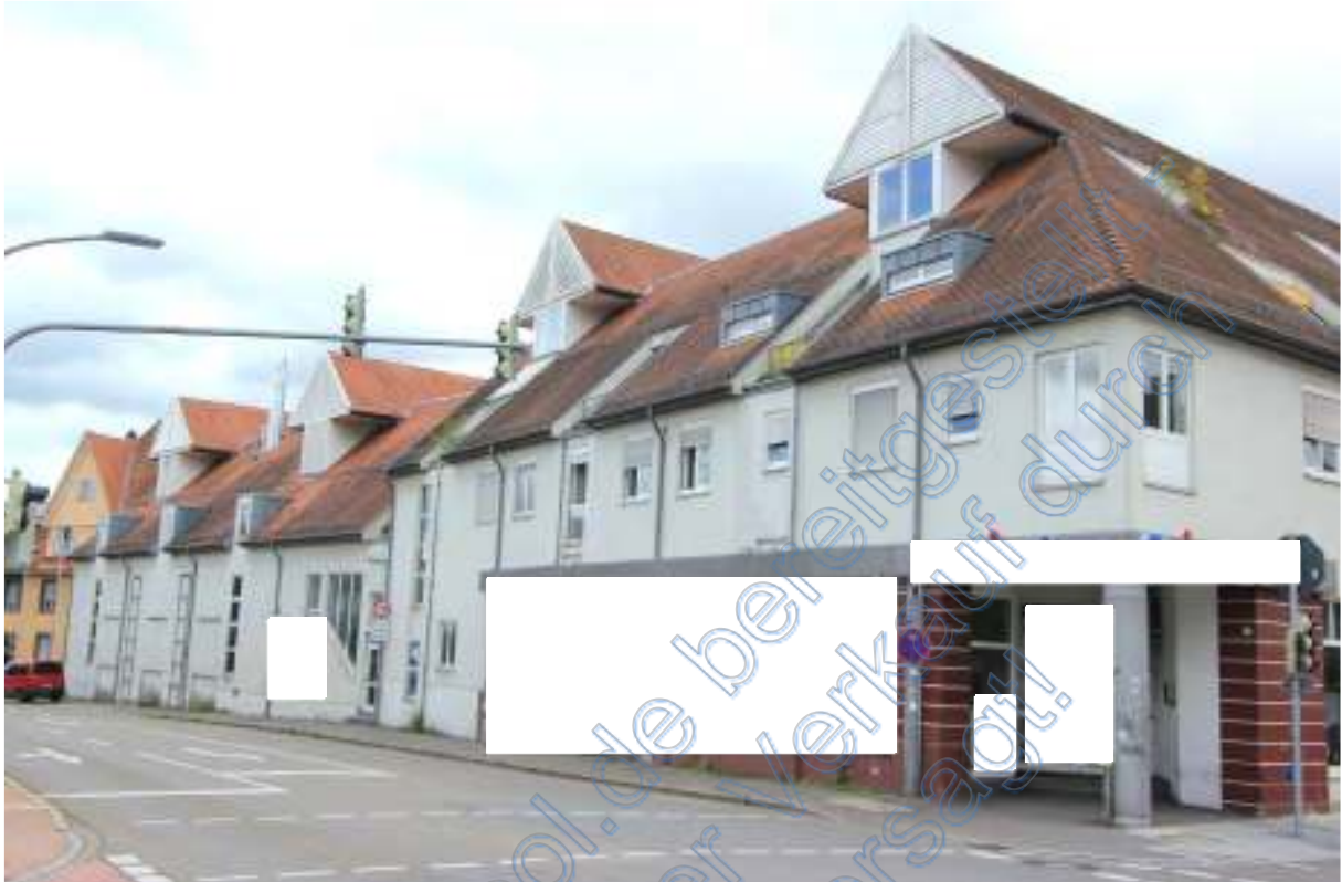
Nordseite Eigumsanlage am Bismarckring
