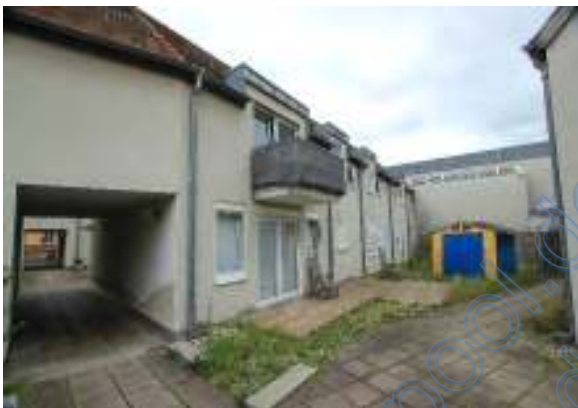
Mittlerer Hinterhof, Blick nach Südosten
