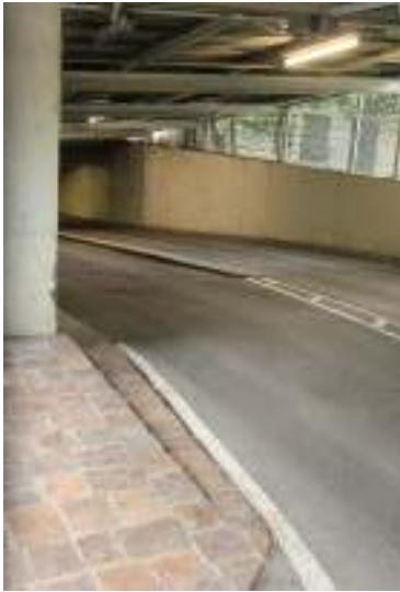
Tiefgaragenzu- und -ausfahrt
