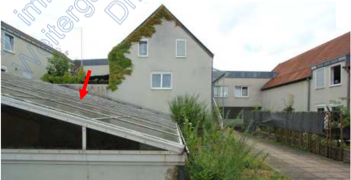
Blick nach Norden, Pfeil Lichtdach über dem Geschäftszentrum
