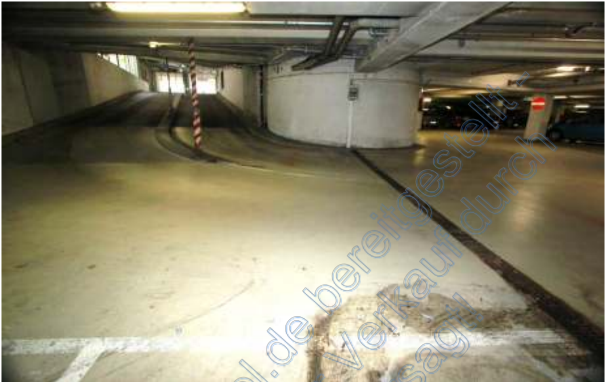
Tiefgaragenzufahrt als Abfahrt links, TG-ausfahrt als Auffahrt
