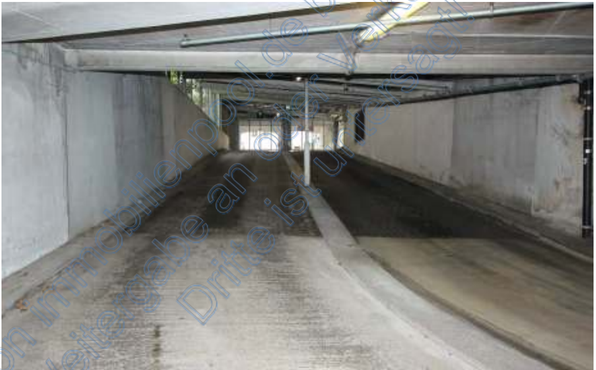
Tiefgaragenzufahrt als Abfahrt links, rechts TG-ausfahrt als Auffahrt
