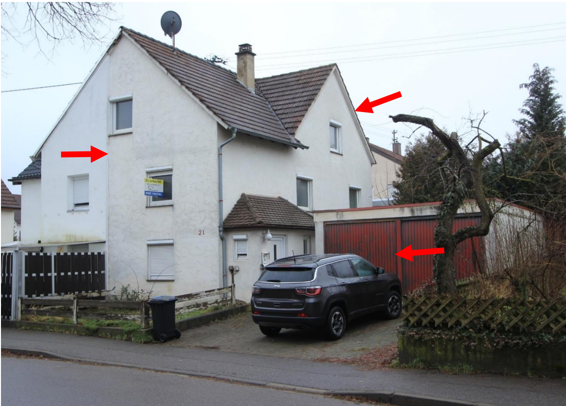
Grundstück von Nord/Nordosten, Pfeile nördlicher Wohnhausteil 21 und Garage
