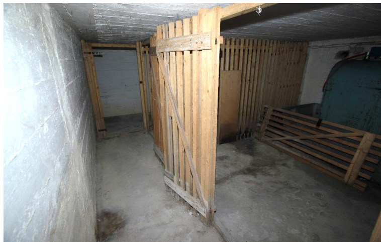
Flur und Abstellräume unter der gesamten Doppelgarage
