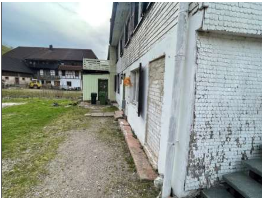
Bild 10: EG, Blick an der Südostfassade zum Anbau
