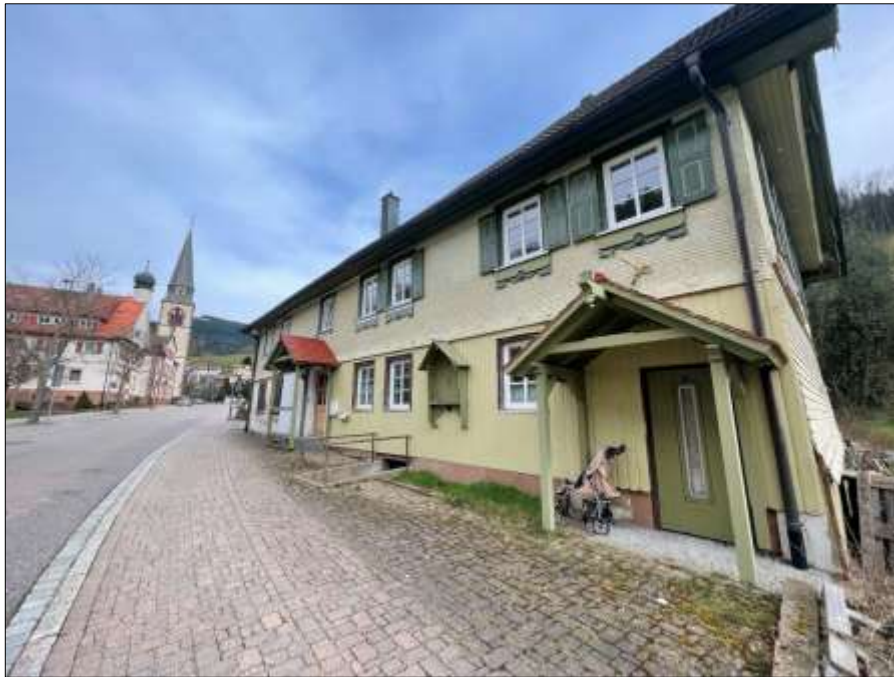
Bild 5: Nordwestfassade, Eingang EG West
