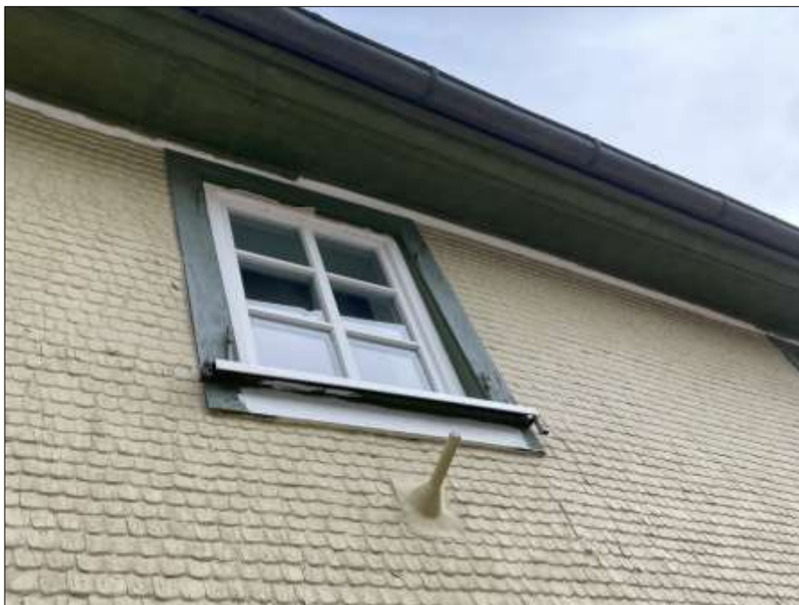
Bild 6: Detail – Holzschindelverkleidung
