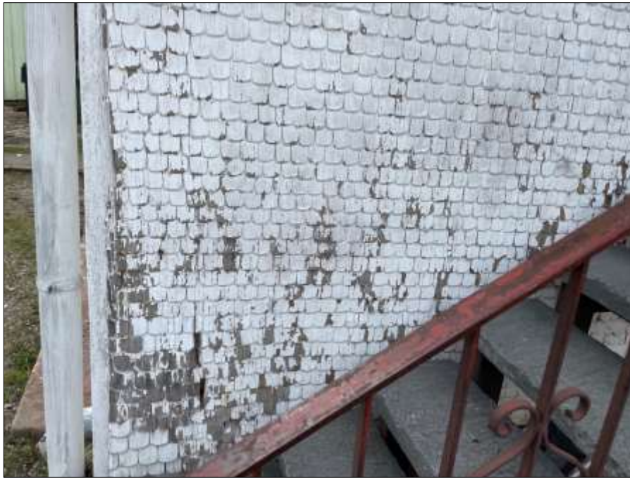
Bild 13: Detail - Holzschindelverkleidung
