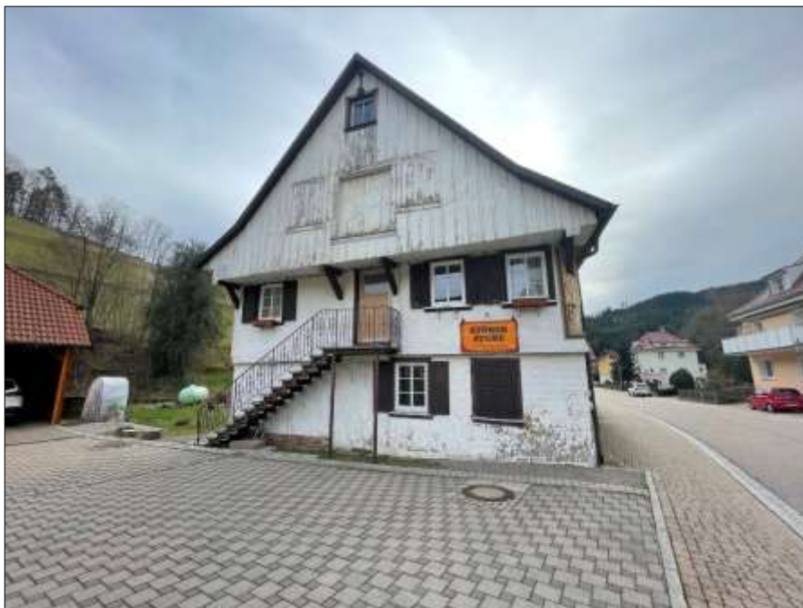
Bild 12: Nordostfassade, Eingang zum OG
