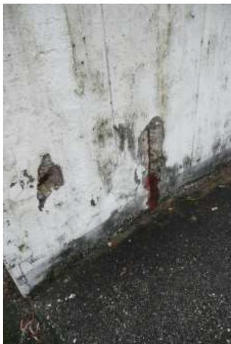
*Schäden seitliche Stützmauern der Garagenzufahrt*
