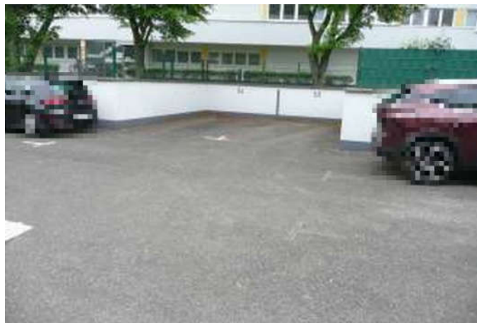
Stellplatz Nr. 58 im Freien
