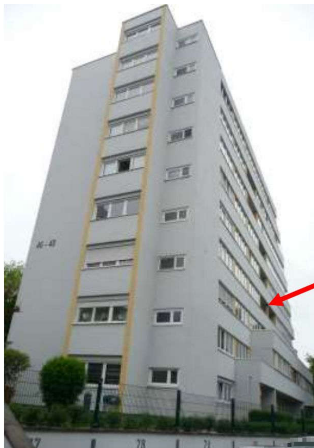
Laubengang im 3. Obergeschoss zur Wohnung (Ostseite)
