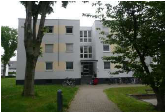
Haus Nr. 40, Norden
