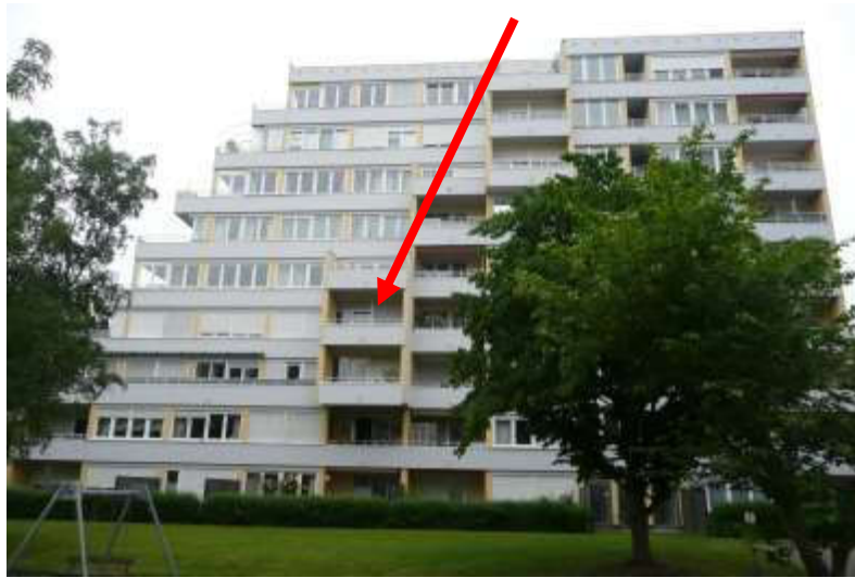
Wohnung im 3. Obergeschoss (Westseite)
