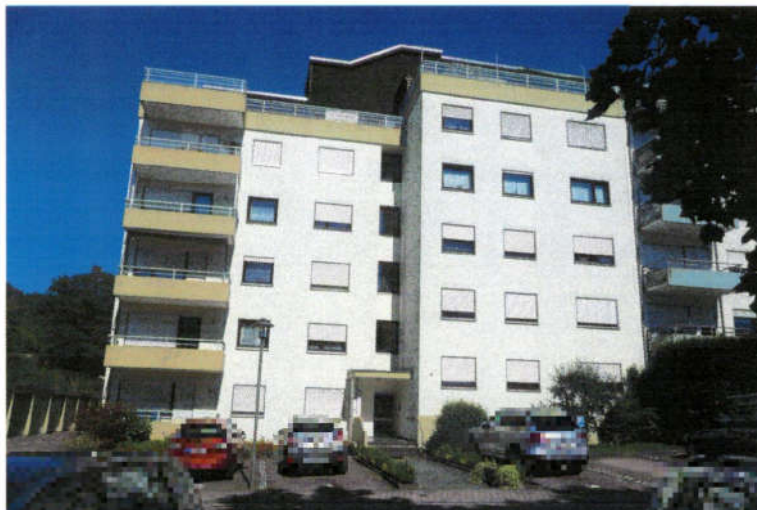
Ansicht von Westen
