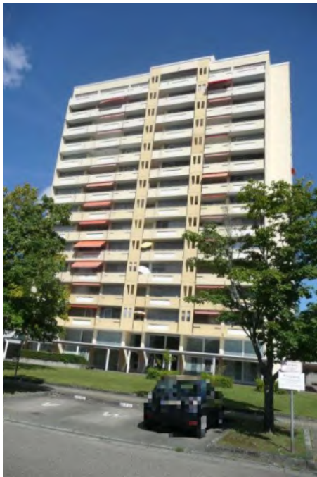
Ansicht von der Barlachstraße (Westen)
