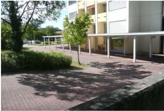
Zugang von den Stellplätzen an der Südostseite des Gebäudes
