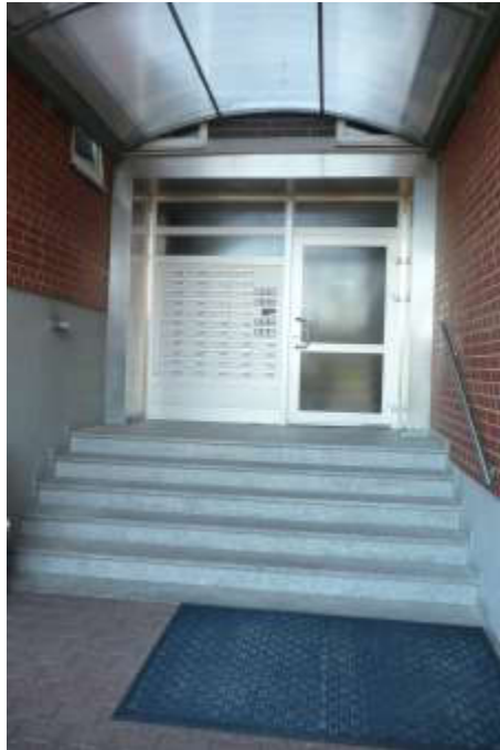
Hauseingang an der Südwestseite
