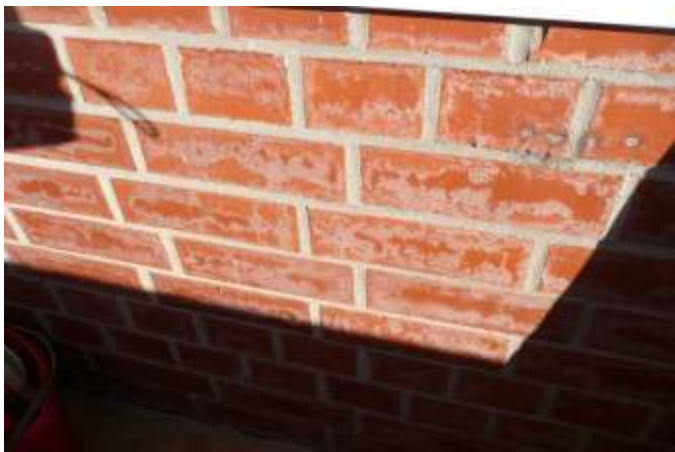
schadhafte Klinker Balkon
