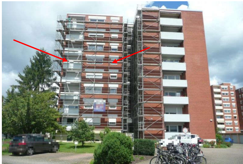
Ansicht von der Straße, Lage der Wohnung markiert
