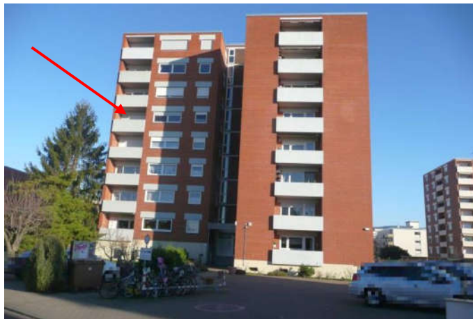
Ansicht von der Straße, Februar 2023
