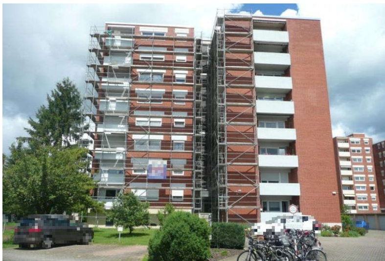
Gesamtgebäude, Ansicht von der Straße „Hinter der Mühle“
