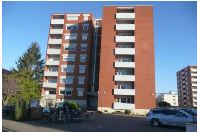
Ansicht von der Straße, Februar 2023
