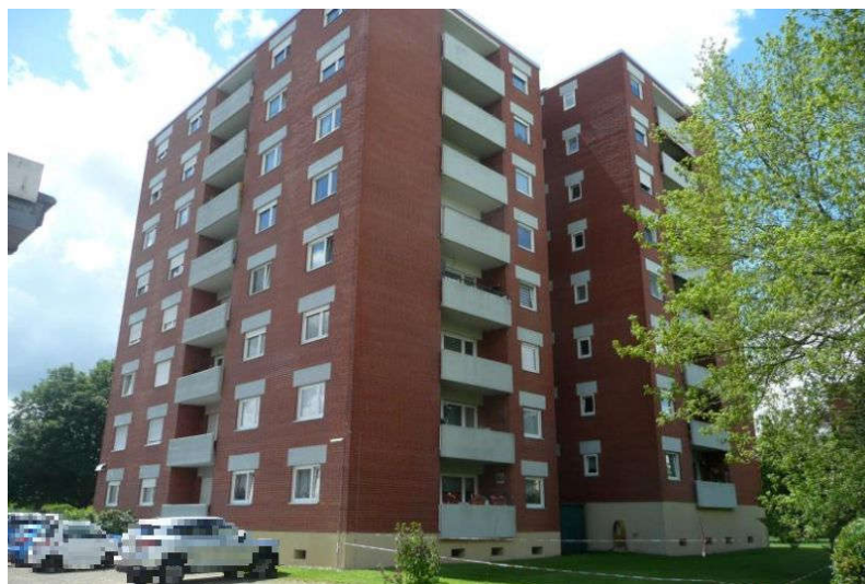
Ansicht vom Garagenhof, Gebäuderückseite
