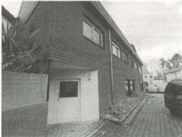
Eingang zur Teileigentumseinheit Nr. 12 im Bereich der südwestlichen Gebäudeecke
