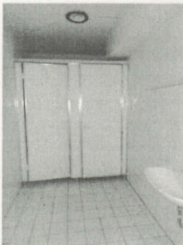
Linkes Bild: Beispiel Toiletten der Teileigentumseinheit Nr. 12; rechtes Bild: Heizungsraum des Gebäudes in der Teileigentumseinheit Nr. 12
