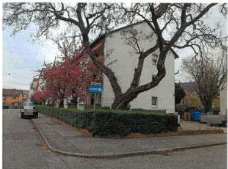
Ansicht Augusta- straße 3 von Süden, Kreuzung Augusta- straße/Victoriastraße
