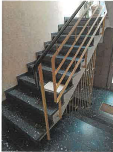
Linkes Bild: Geschosstreppe zum Obergeschoss; rechtes Bild: Wohnungseingangs- tür im Erdgeschoss
