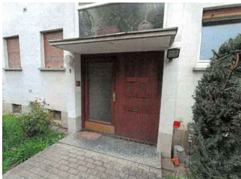
Hauseingang Augustastrasse 1 auf der östlichen Traufseite
