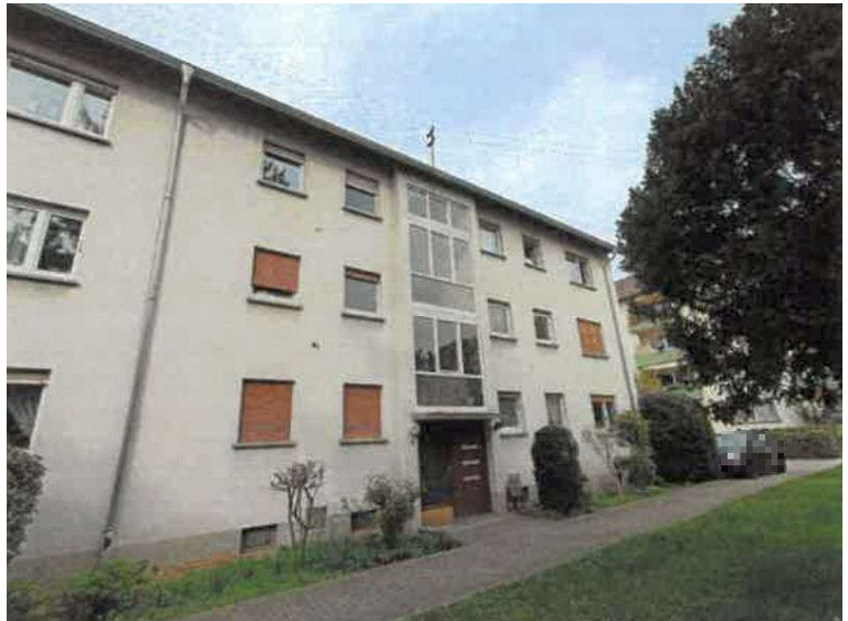
Ansicht von Südosten, Augustastrasse 1
