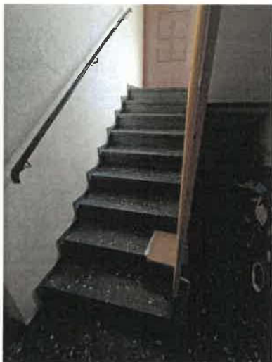
Linkes Bild: Geschosstreppe vom Untergeschoss zum Hauseingang; rechtes Bild: Waschküche im Untergeschoss
