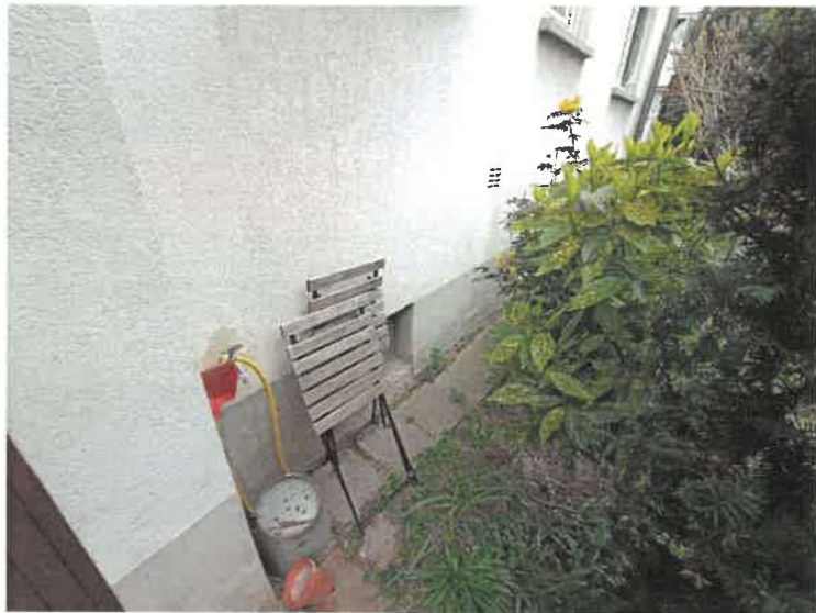
Sockel und Fassade auf der östlichen Traufseite nördlich der Haustür zur Augustastraße 1
