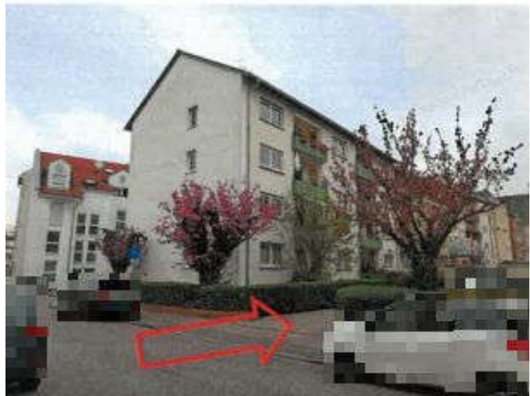
Gebäude Heinrich- Fuchs-StraÙe 17 von Südwesten, roter Pfeil zur Zufahrt zum PKW-Stellplatz und zum Hauszugang AugustasträÙe 1
