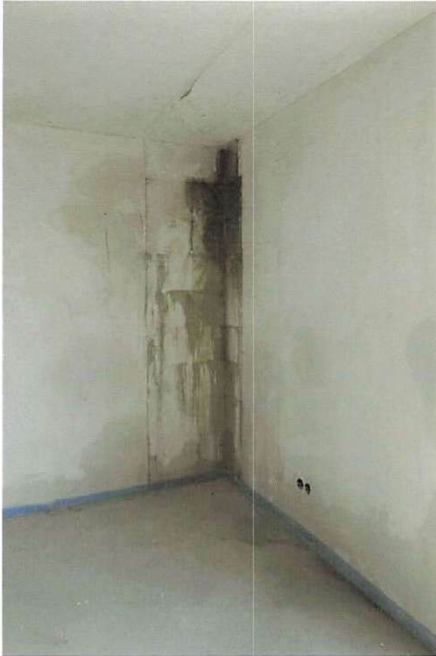
Foto 49 Whg. 4, OG, Wohnen/Essen, Südwand (links) und Westwand (rechts)
