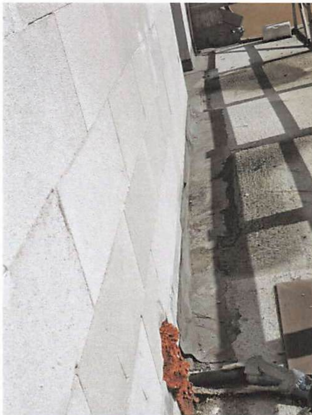
Foto 61 Bildfortsetzung zu obigem Foto nach Süden.
