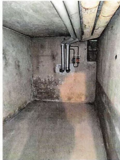
Anschluss Fernwärme
