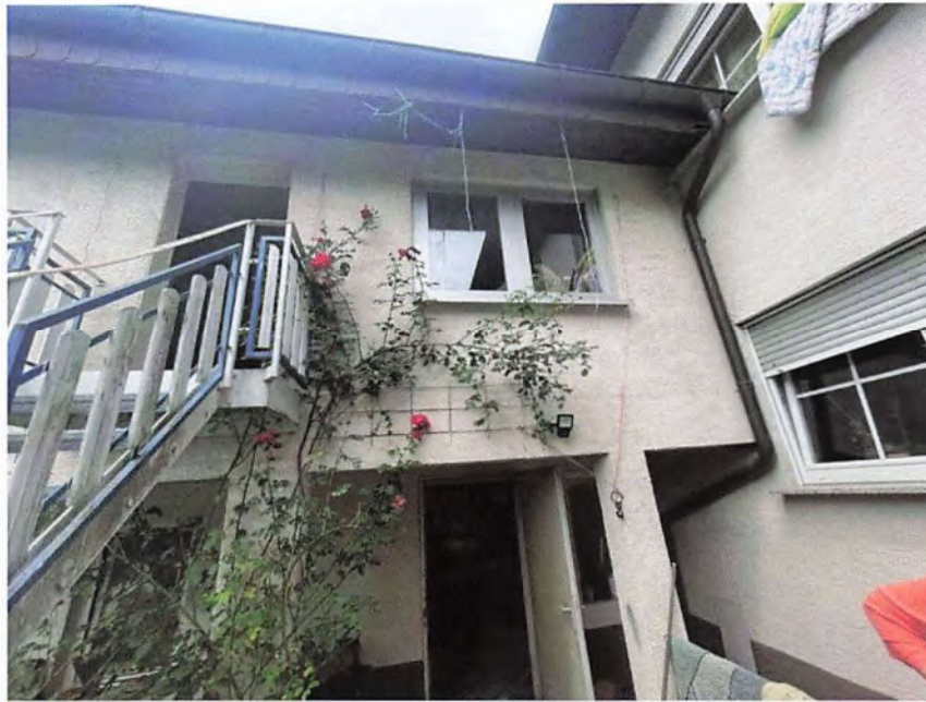
Bild 11: Anbau an/über Garage
