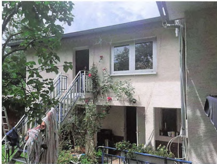
Bild 9: Anbau an/über Garage (ohne sichtbare Genehmigung errichtet)
