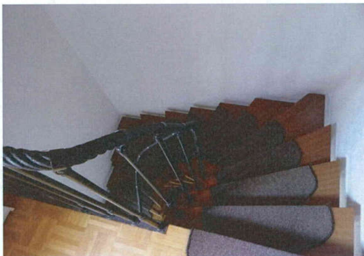
Foto 18: Treppe vom Erdgeschoss zum Dachgeschoss
