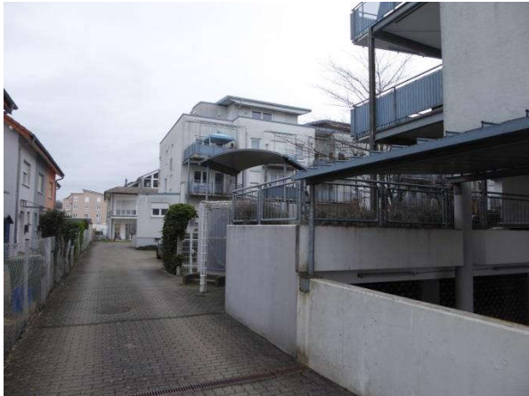
5. Blick von Süden (Westseite des Anwesens)
