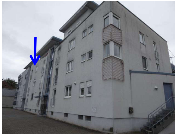
4. Blick von Nordwesten
