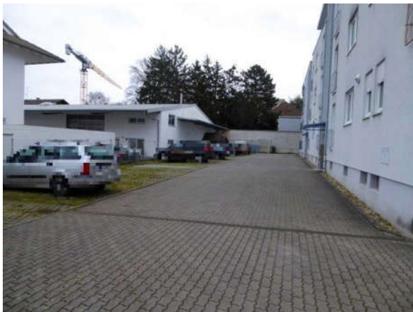
3. Blick von Osten (Nordseite des Gebäudes)
