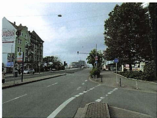
Czernyring in Richtung Südwesten
