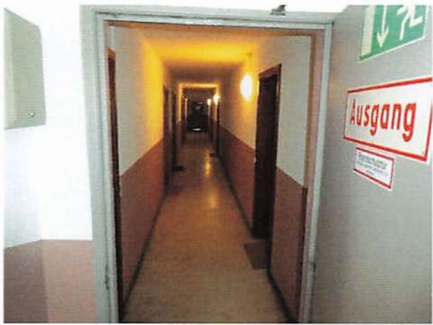
Erschließungsflur | drittes OG | Haus III
