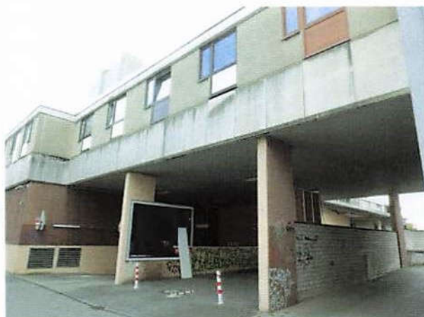
Zufahrt zur Tiefgarage
