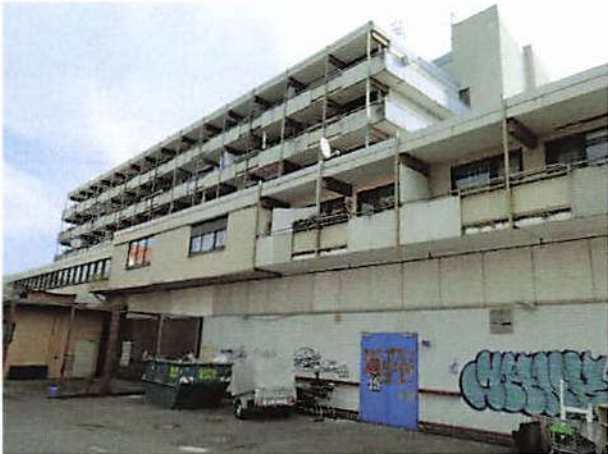
Westansicht Gebäude III.
