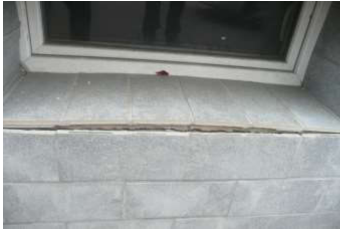
schadhafter Mauersockel an der straßenseitigen Fassade
