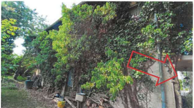
Ansicht nordöstliche Traufseite, roter Pfeil zum Hauseingang
