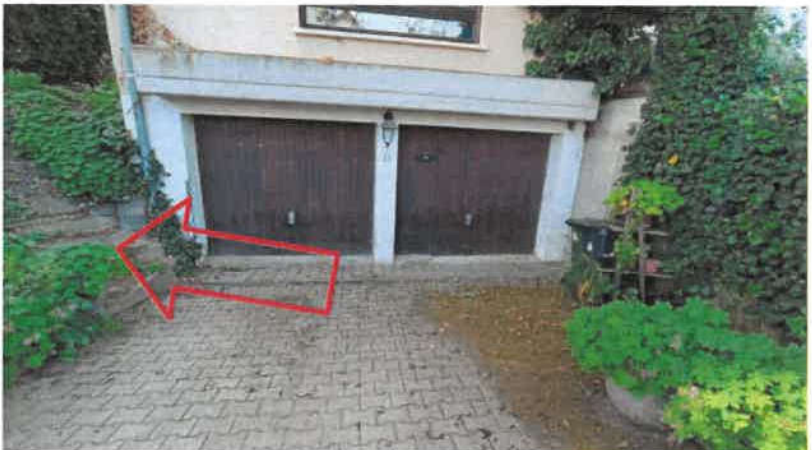
Garagen im Unter- geschoss, roter Pfeil zum Hauseingang
