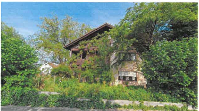
Ansicht von Südosten (Im Mainzer)
