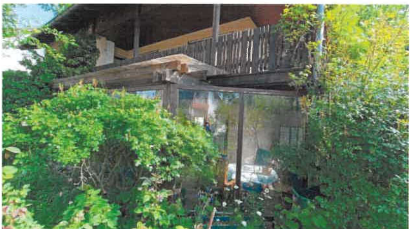
Wintergarten im Erdgeschoss und Balkon im Oberge- schoss auf der südwestlichen Traufseite
