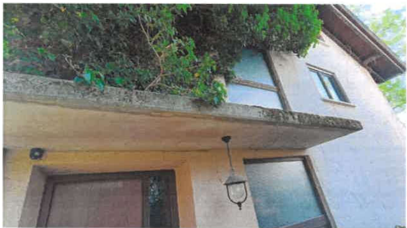
Beispiel für Pflanzenbewuchs, hier: Hausgangs- überdachung auf nordwestlicher Giebelseite
