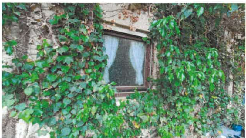
Beispiel für Fenster, hier: Badezimmer Erdgeschoss
