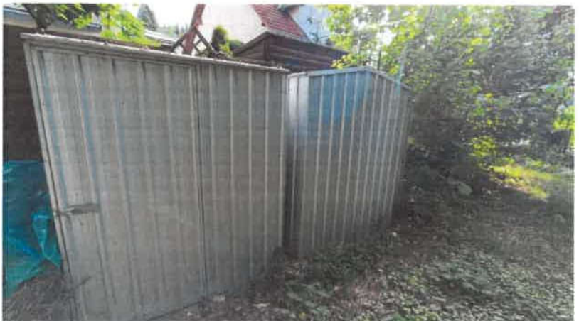
Gartengeräte- schuppen im Bereich der nördlichen Grundstücksecke
