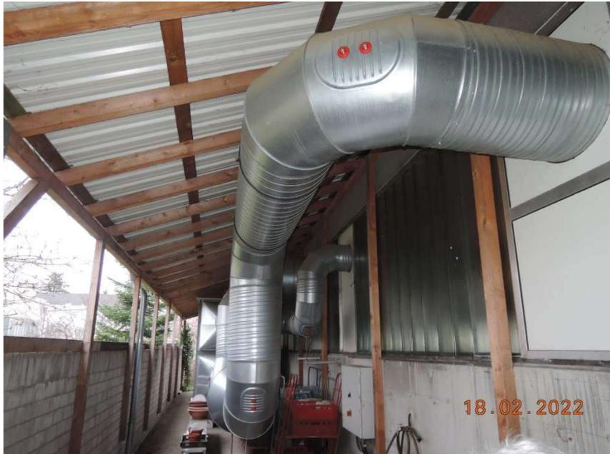
Bild 13: Lüftungsanlage mit Wärmerückgewinnung (Nordwestseite)
