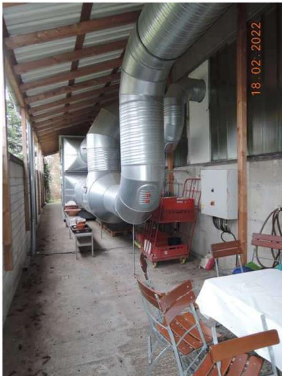
Bild 14: Lüftungsanlage mit Wärmerückgewinnung (Nordwestseite)
