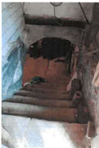
Beispiel für Treppen des Hauptgebäudes (links: zwischen EG/KG; rechts: zwischen EG/OG)
