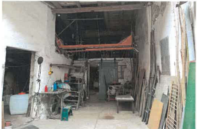
Ansicht von Hof auf nordwestlichen Teil der Scheune
