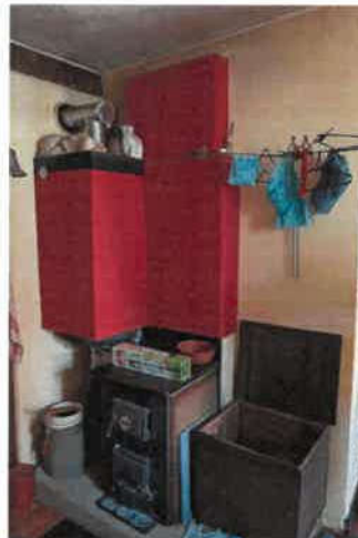
Beispiel für technische Ausstattung des Hauptgebäudes (links: Einzelofen im OG- Wohnzimmer; rechts: Stromkasten im OG- Flur)
