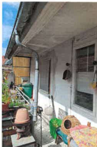
Ansicht von Obergeschoss des Hauptgebäudes (Balkon) auf südöstlichen Teil des Hauptgebäudes mit Balkon und Anbau
