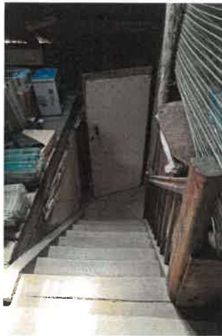
Beispiel für Treppen des Hauptgebäudes (links: zwischen OG/DG; rechts: zwischen DG/Spitzboden)
