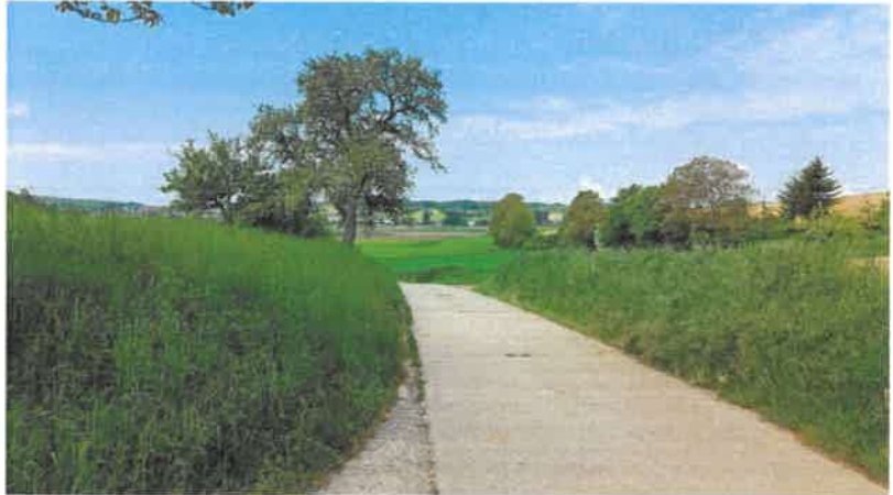
Eschelbronner Straße in Richtung Südwesten (nach Zuzenhausen) links Einmündung des Grünwegs zum Bewertungs- grundstück
