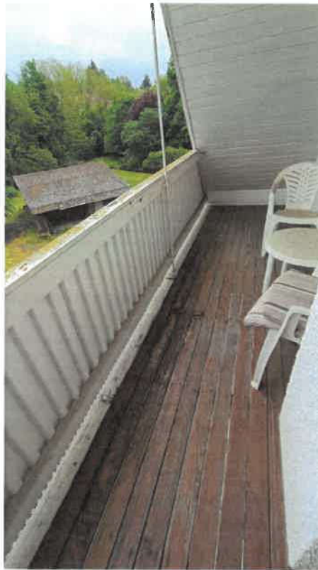
Schadhafte Holzbau- teile, Dachgeschoss Bereich Balkon
