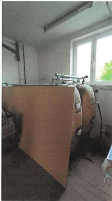
Beispiel technische Gebäudeausstattung hier: Öltanks, Werk- stattraum, Erdge- schoss, „Altbau“
