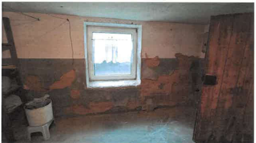
Aufsteigende Feuchtigkeit im Kellergeschoss
