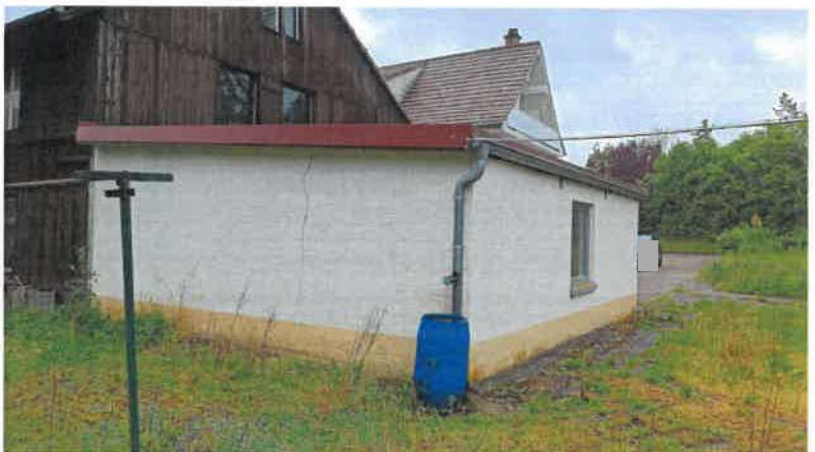
Riss in Fassade auf Südost-Seite der Garage
