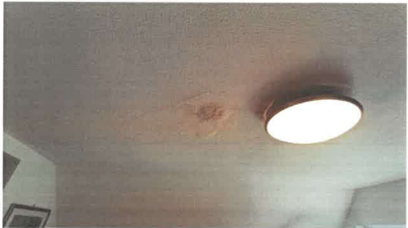
Wasserschaden, Decke Wohnbereich Dachgeschoss
