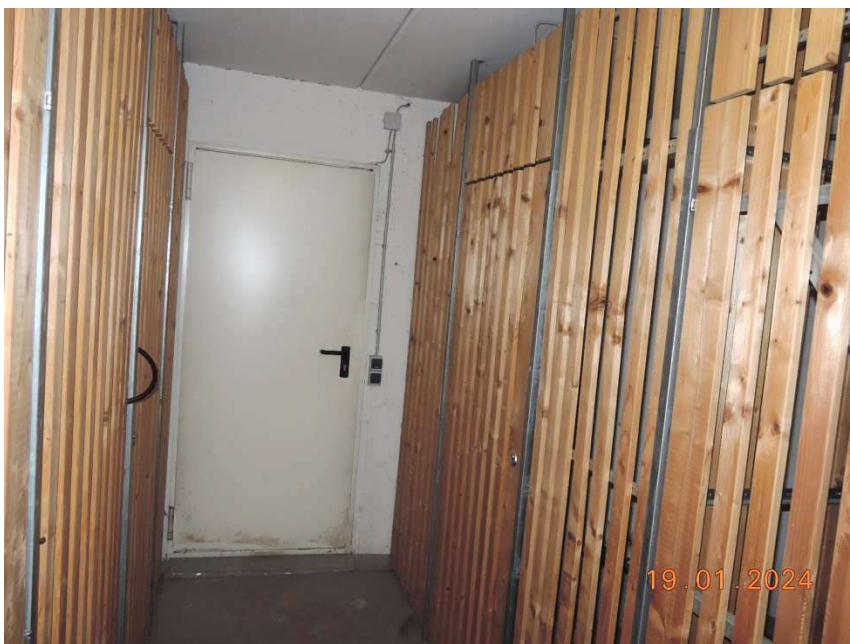
Bild 12: Kellerräume und Zugang zum Garten
