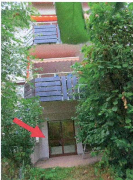
Terrasse der Wohnung Nr. A 2
