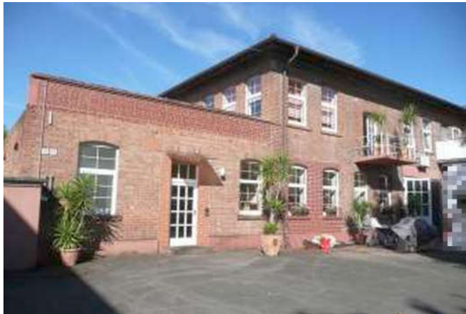
Gebäude Haus 3 (III) von Südosten
