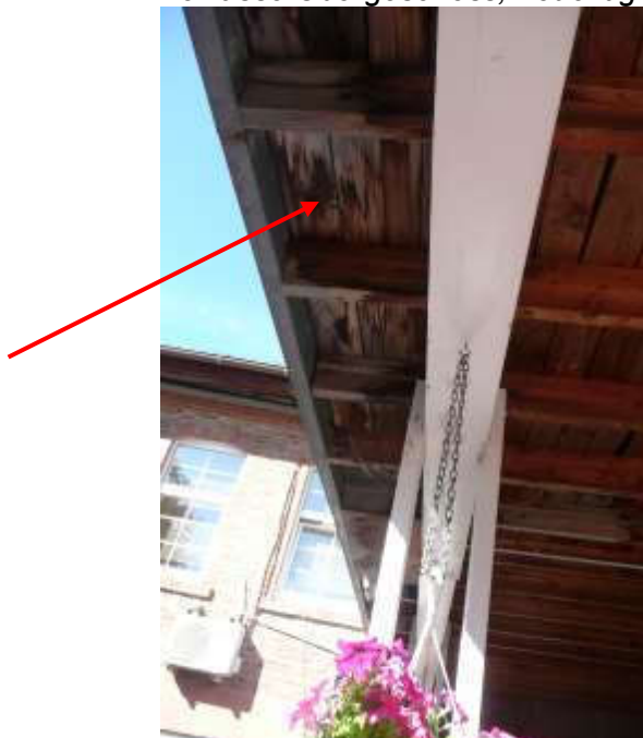
Terrasse Obergeschoss, Feuchtigkeitsschäden in Holzdielen und Geländer
