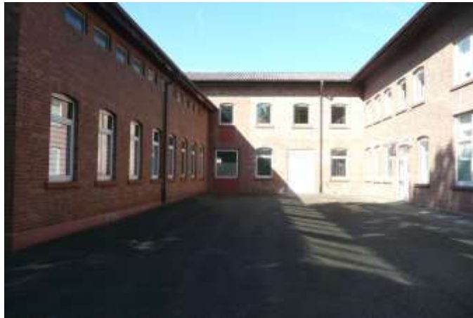
Gebäude IV, Teil B links, Teil A, geradeaus, Gebäude V rechts
