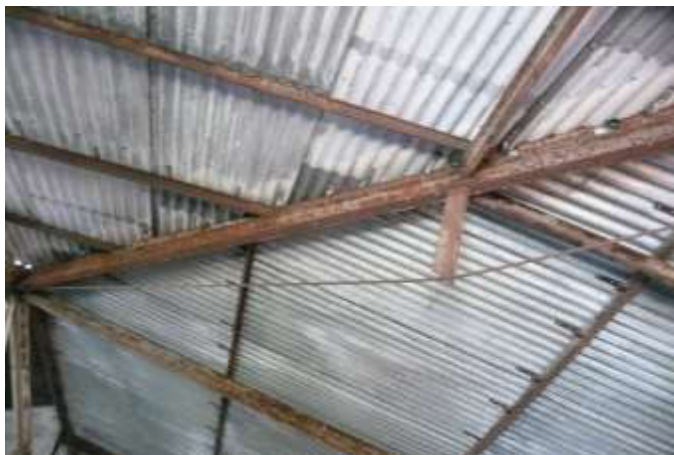
schadhafte Dachkonstruktion
