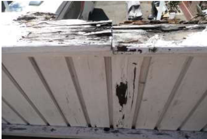
Terrasse Obergeschoss, Feuchtigkeitsschäden in Holzdielen und Geländer
