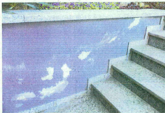
Feuchtigkeitsschäden in den Stützmauern der Aufgangstreppen zu den beiden Wohnungen
