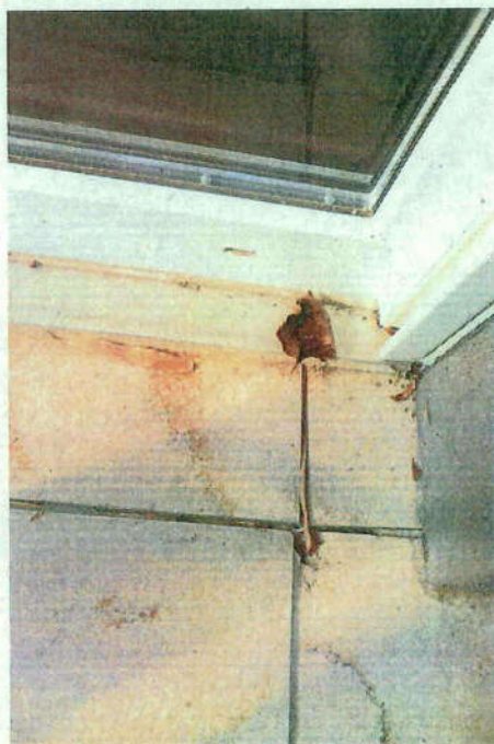
Feuchtigkeitsschäden Terrasse auf der Garage und an der Überdachung
