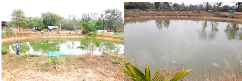
การธนาคารน้ำใต้ดินระบบบ่อเปิดที่อำเภอบรบือ จังหวัดมหาสารคาม เพื่อการแก้ไขปัญหาน้ำเค็ม
