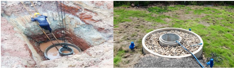
ลักษณะ: ฐานการน้ำใต้ดินระบบบ่อมหัศจรรย์ทูอินวัน แบบใส่ท่อ 2 วง
