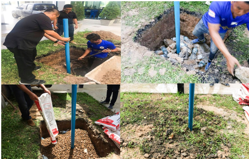
การดำเนินการน้ำใต้ดินระบบบ่อปิดแบบบ่อขุด
