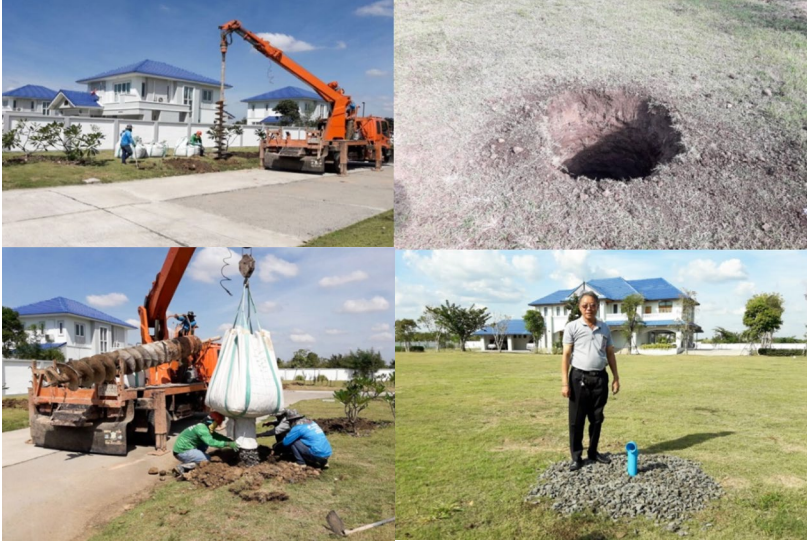
การดำเนินการน้ำใต้ดินระบบบ่อบปิดแบบบ่อเจาะ
