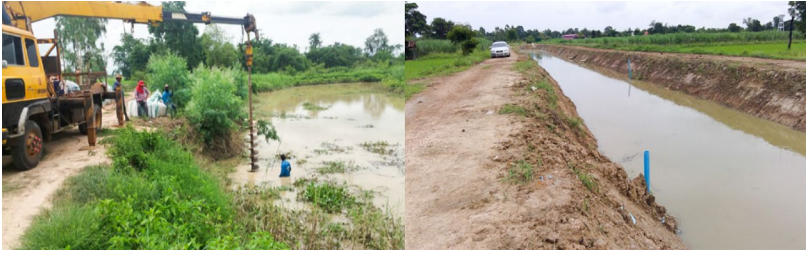
การแก้ไขบ่อเดิมด้วยหลักการธนาคารน้ำใต้ดินแบบเจาะกรณีบ่อเดิมมีน้ำ
