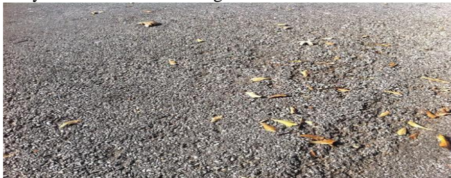
Fig. Raveling (very porous asphalt)
