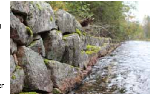
Hengebrua over Bjørnsjøhelvete
