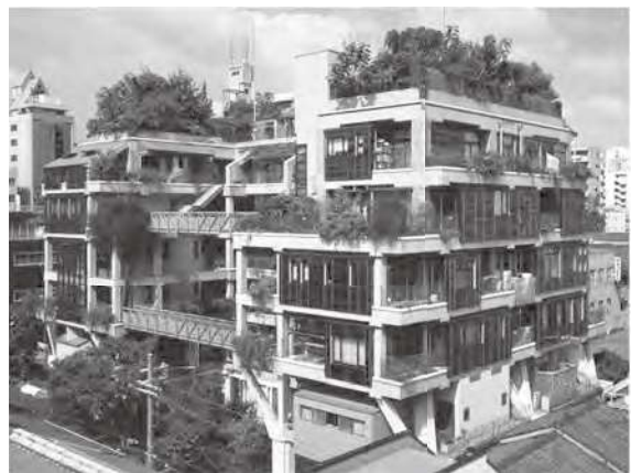
現代のスケルトン・インフィル方式による集合住宅 (実験集合住宅NEXT21)
