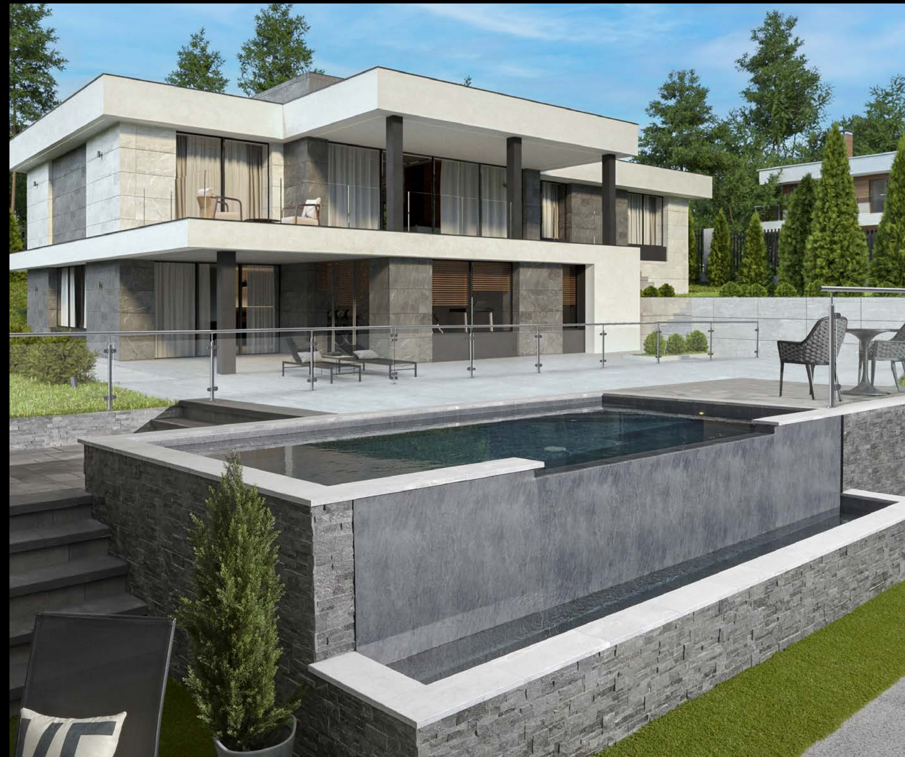
28 TRÉVI INFINITY Piscine structure à haut relief à débordement / Béton armé High relief structure overflow pool / Reinforced concrete
