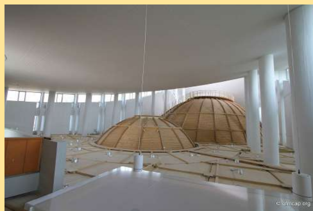
Particolare dell'estradosso delle due cupole interne
