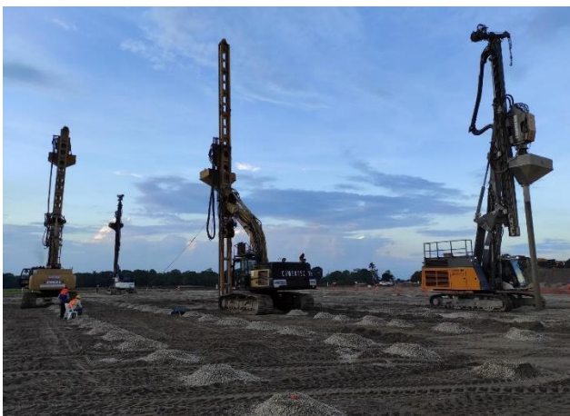
Figure 10. Instalación de las pilas de grava compactada en el área a acelerar el proceso de consolidación.
