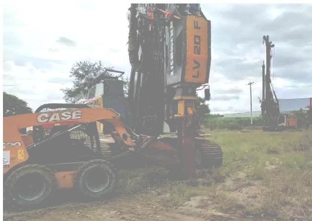
Figura 3. Construcción de Pila de Agregado Compactado con el sistema X1.
