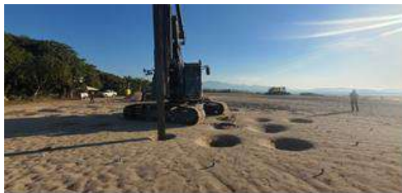
Figura 5. Elementos de agregado compactado con arena del sitio con sistema X1® de desplazamiento.
