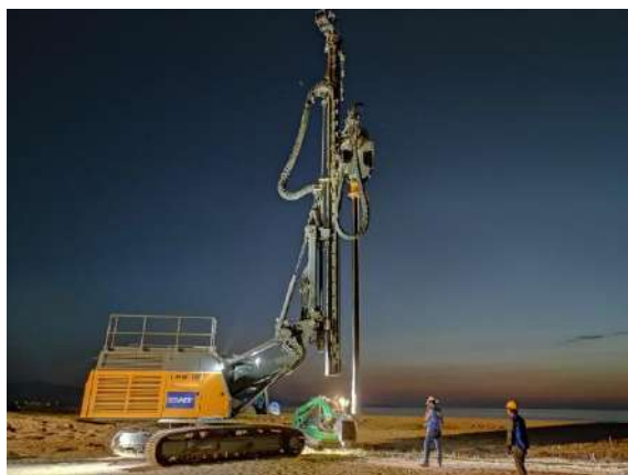
Figura 6. Instalación del sistema X1® de desplazamiento usando arenas del sitio
