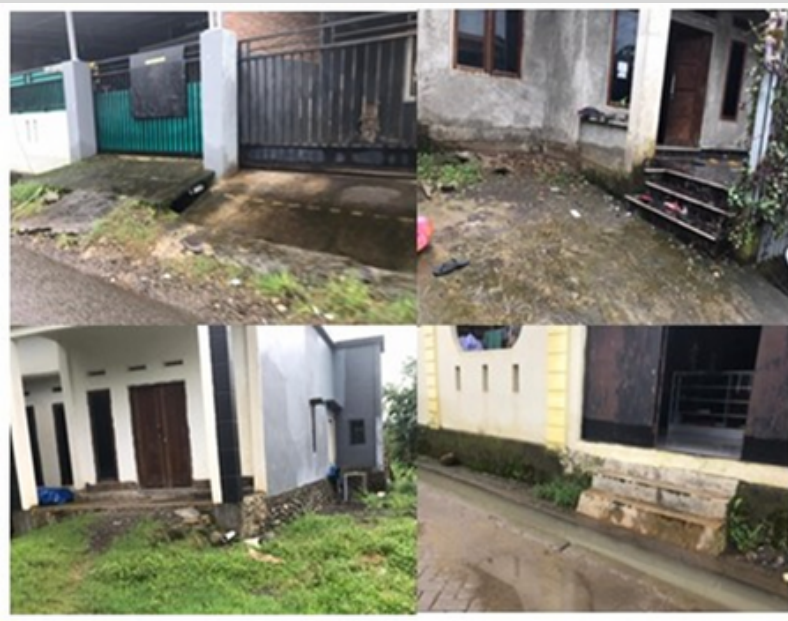
Gambar: Meningkatkan Pondasi Rumah Penduduk di Desa Jenetallasa
