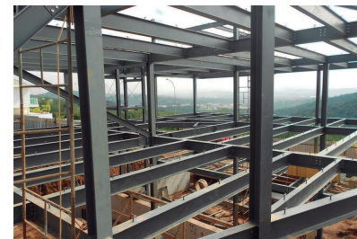
DISEÑO Y FABRICACIÓN DE ESTRUCTURA METÁLICA
