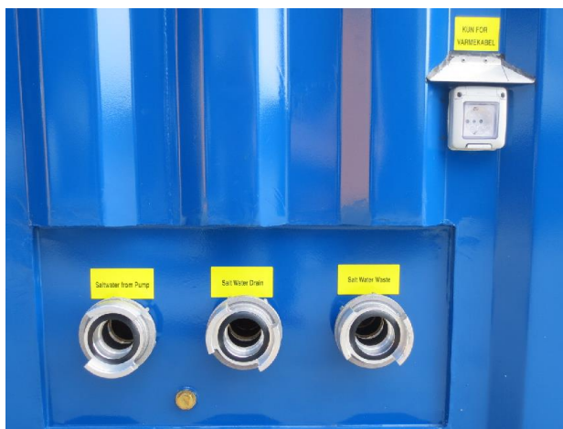
Figur 7 Tilkobling saltvanns side
