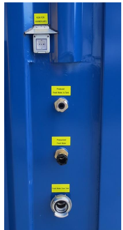
Figur 6 Tilkobling ferskvannside
