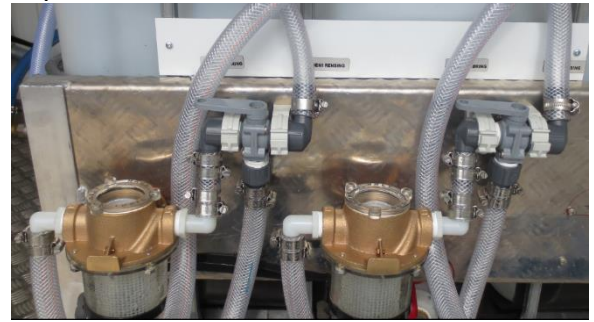
Figur 23 Ventilsett tilførsel (saltvann)
