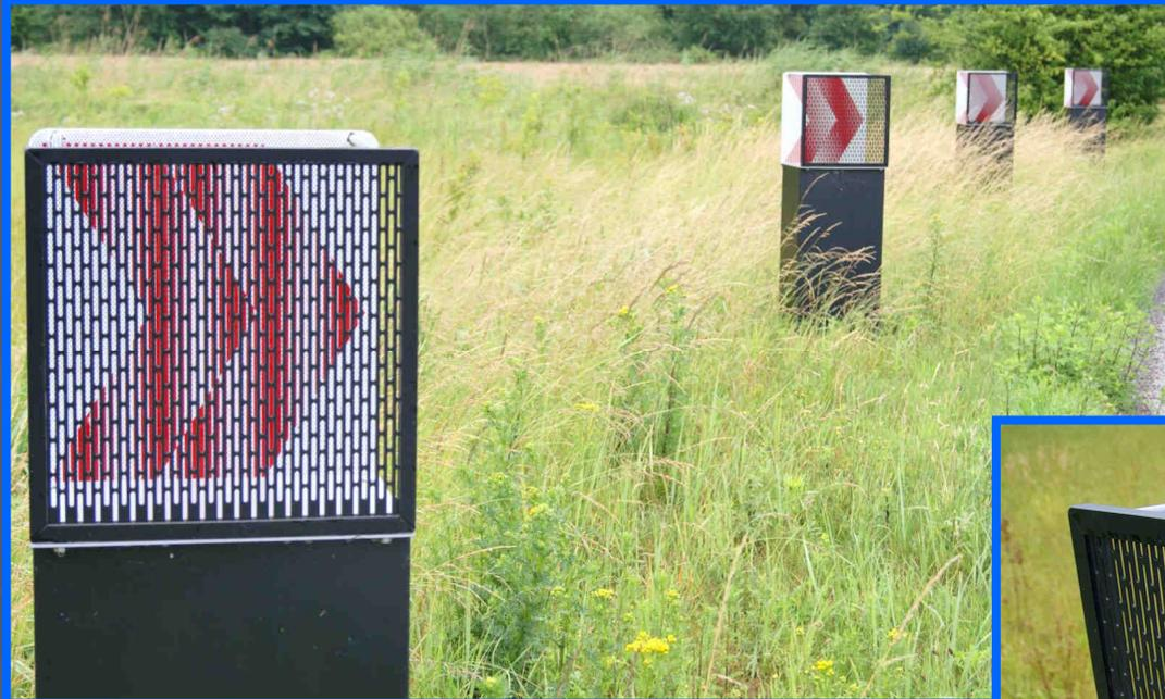
Voici une photo d'une signalisation dans un virage de la rue où j'habite. Les flèches semblent aller en avant par l'effet moiré des deux réseaux de lignes superposés. Il y a une grille métallique au premier plan et un motif de lignes peintes au fond.
