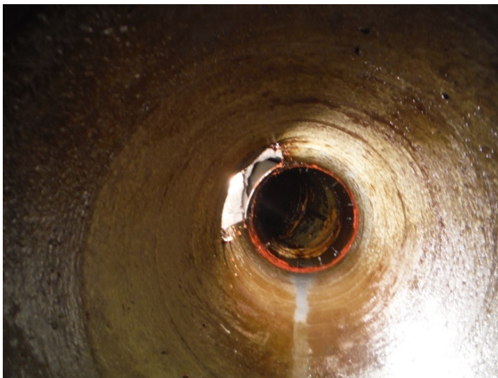
Mismo conducto que el anterior una vez realizada la limpieza, (cortesía de ISNI S.A. de C.V. y de Omakie S.A. de C.V.)
