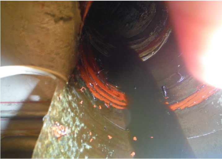
Suciedad en tramos horizontales de conductos de campanas de cocinas industriales, (cortesía de ISNI S.A. de C.V. y de Omakie S.A. de C.V.)
