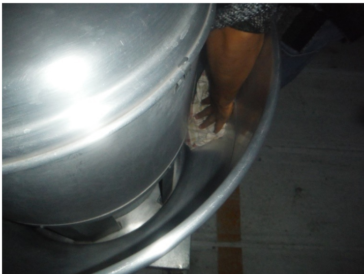
Limpieza del extractor ubicado en la cubierta, (cortesía de ISNI S.A. de C.V. y de Omakie S.A. de C.V.)
